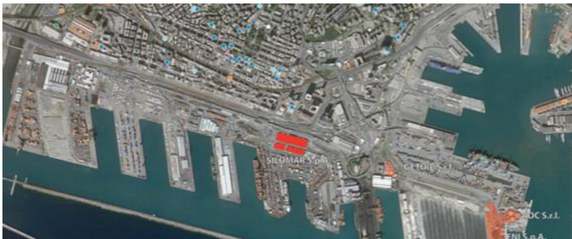
Figura 29 - Ubicazione deposito costiero Silomar S.p.A. con una superficie totale di circa 19.969 mq
