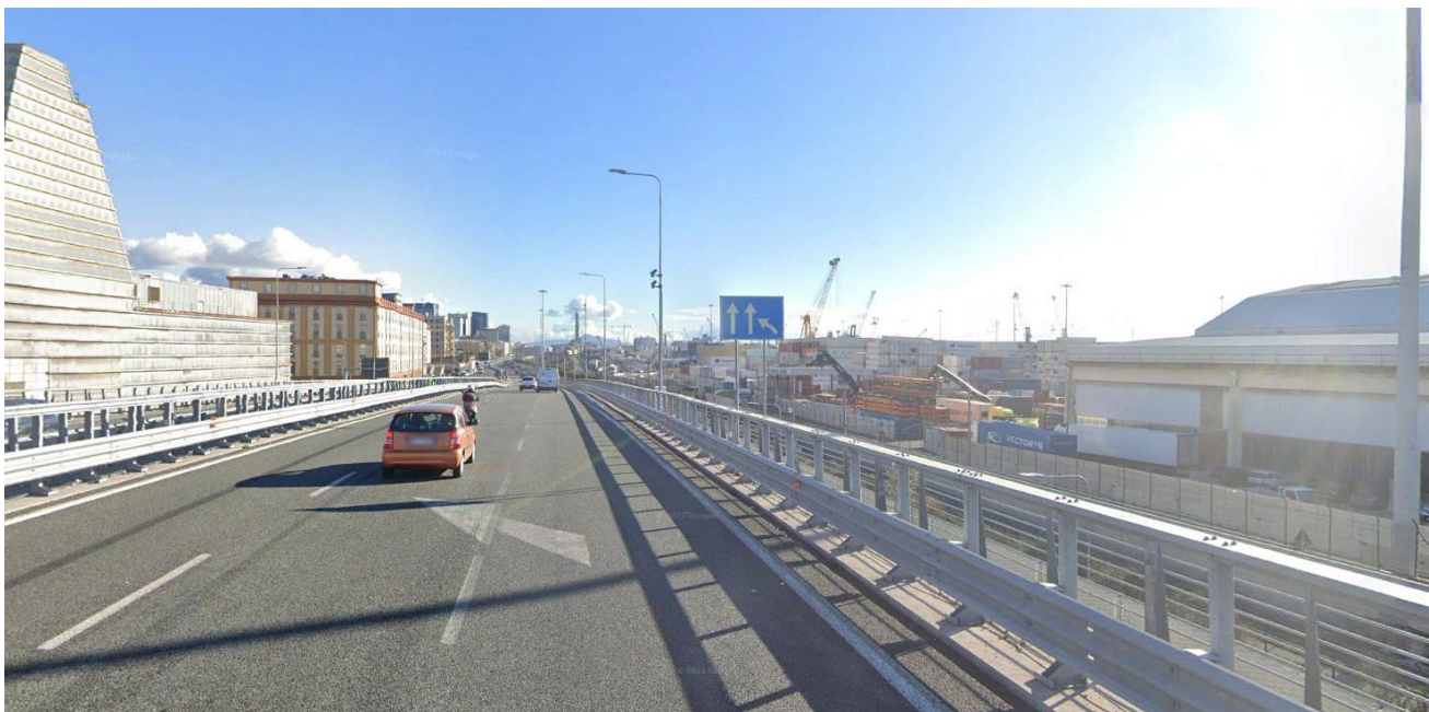
Figura 7-14 Punto di vista dalla strada statale SS1 Aurelia, tratto sopraelevato.
