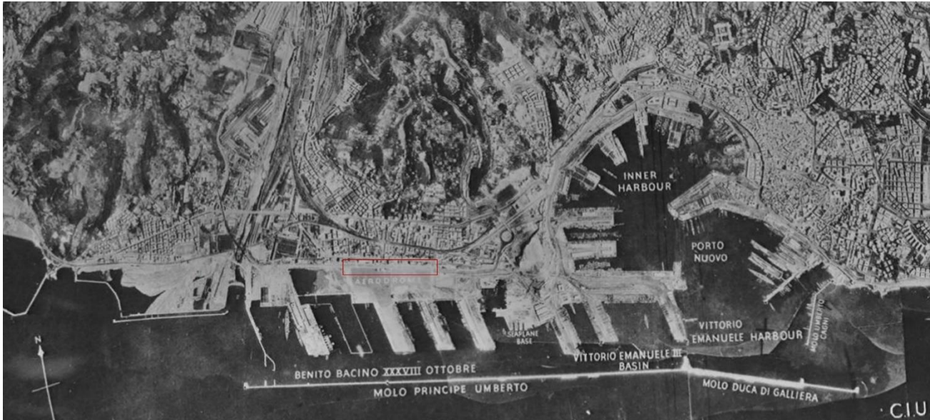
Figura 5-20 Foto aerea dell'area di intervento (in rosso) datata 1943
