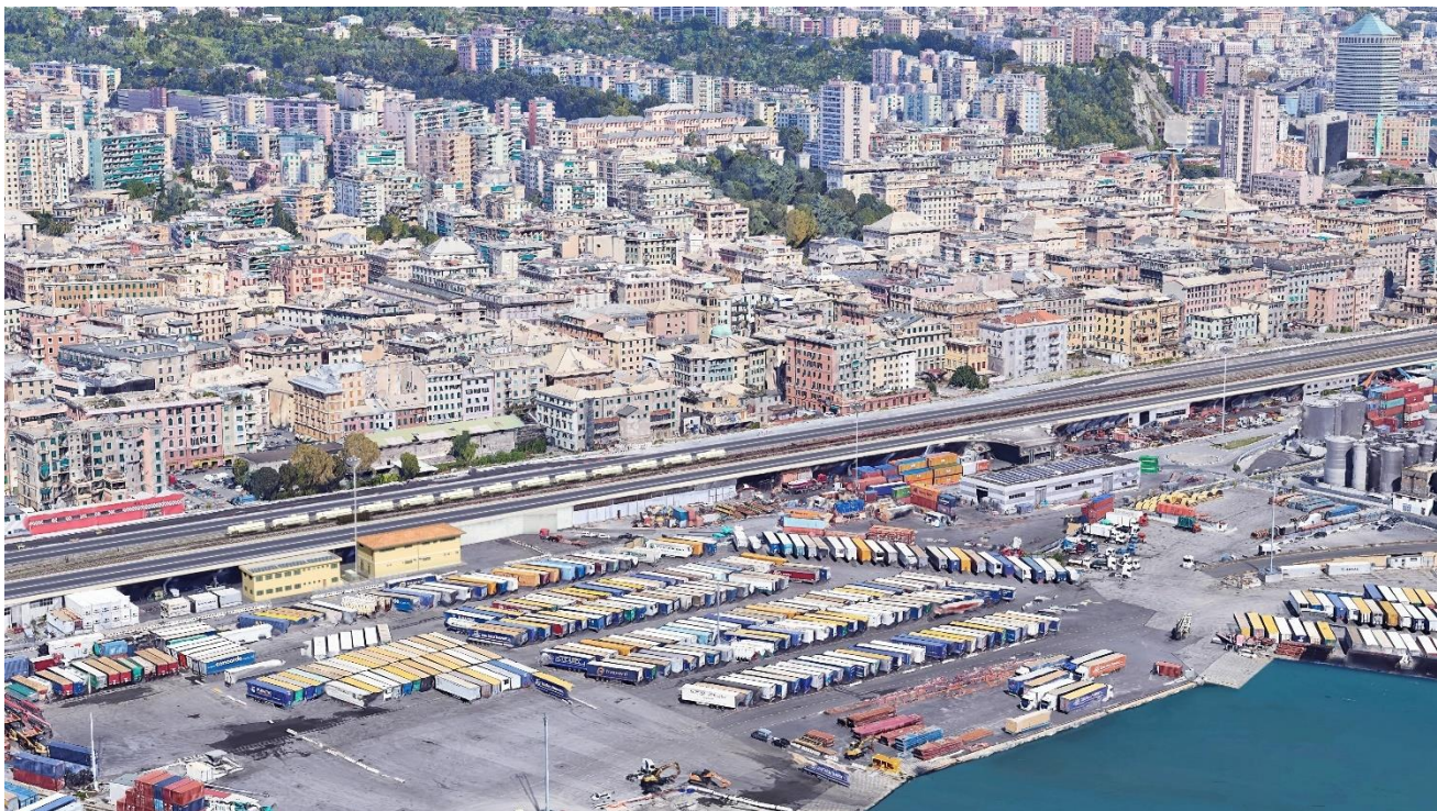
Figura 7-17 Punto di vista F1 Post operam
