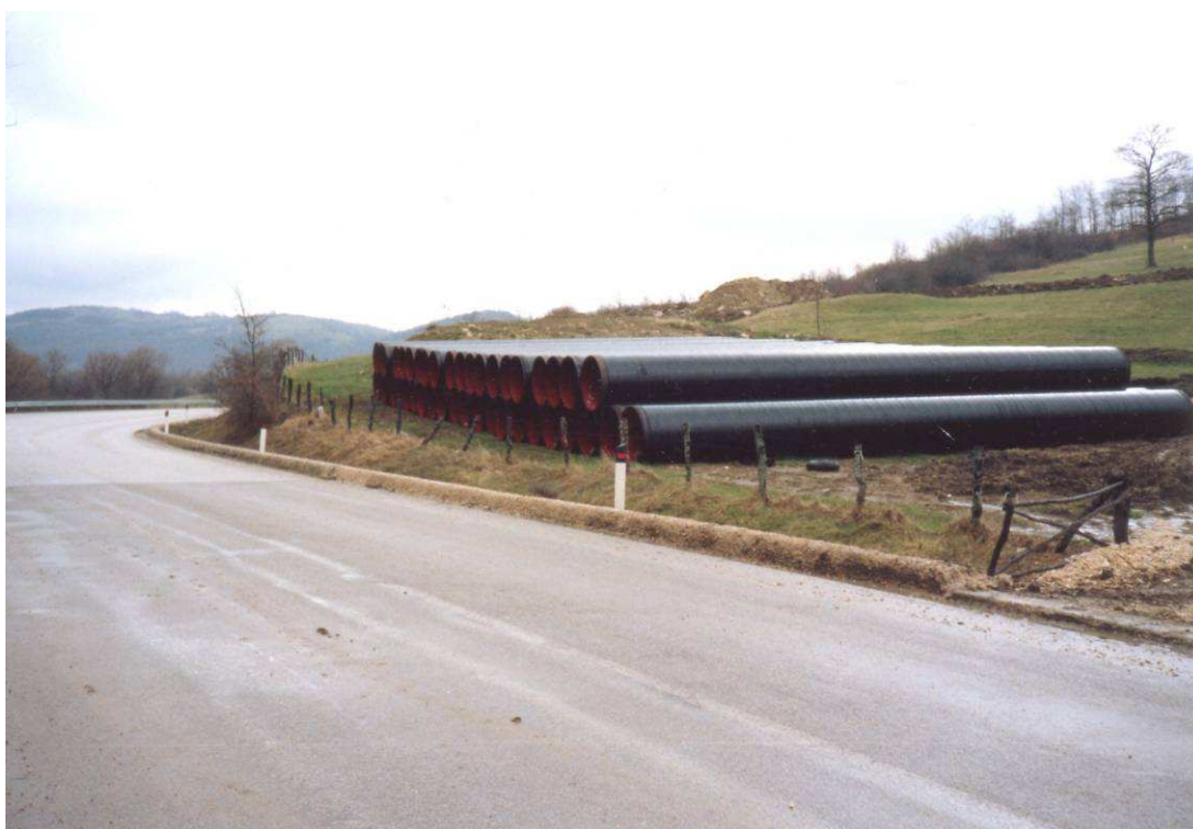
Fig. 2.5 - Piazzole di accatastamento tubazioni.
