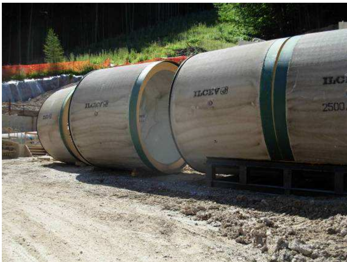
Fig. 2.19 - Stoccaggio tubi in c.a.
