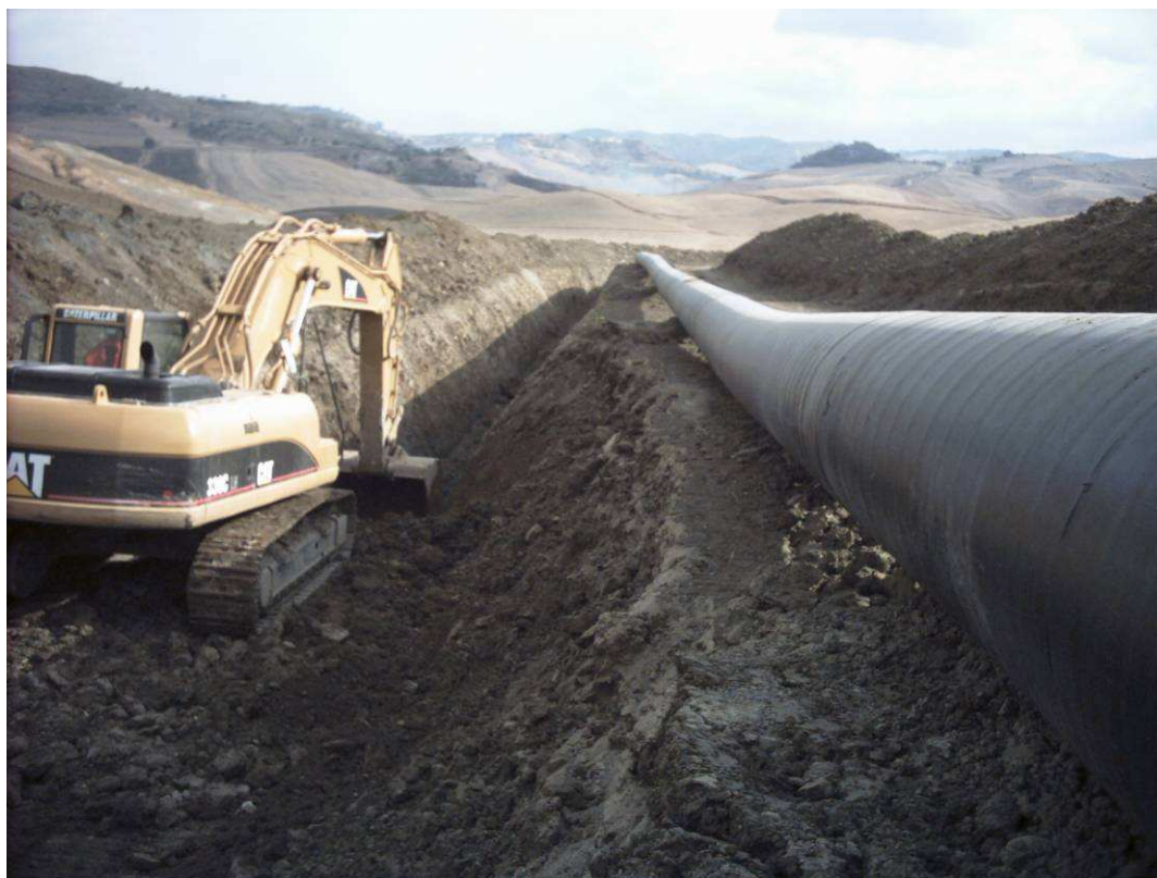
Fig. 2.8 - Scavo per l'alloggiamento della condotta.
