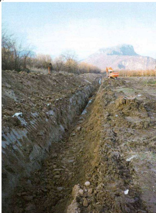
Fig. 2.10 - Operazione di rinterro della condotta.
