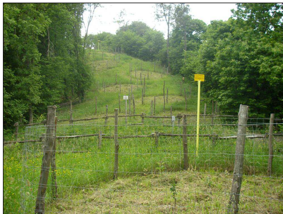
Fig. 2.27 - Ripristino vegetazionale a gruppi protetti con recinti provvisori circolari.
