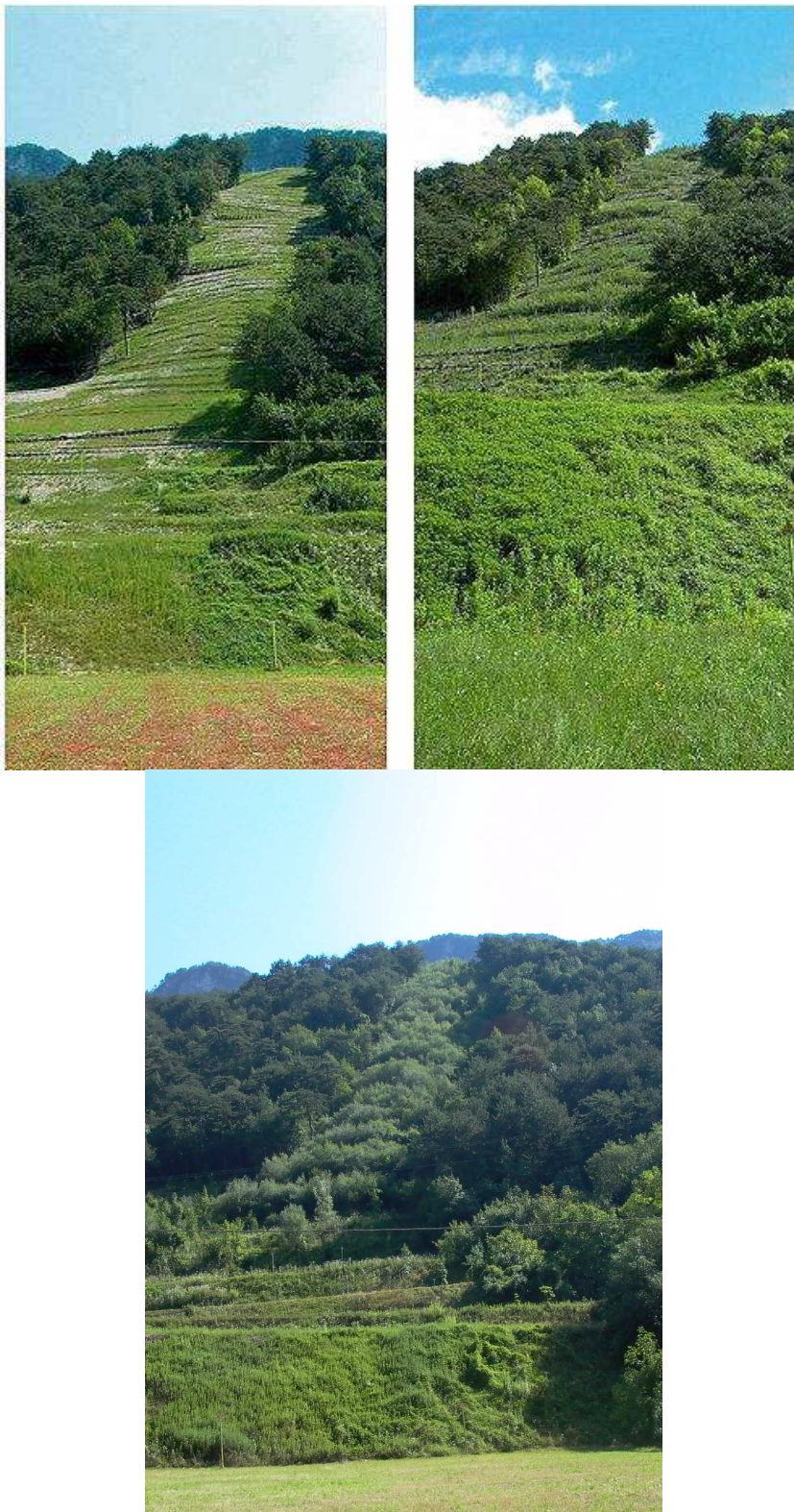
Fig. 2.26 - Evoluzione del ripristino morfologico e vegetazionale di un versante.
