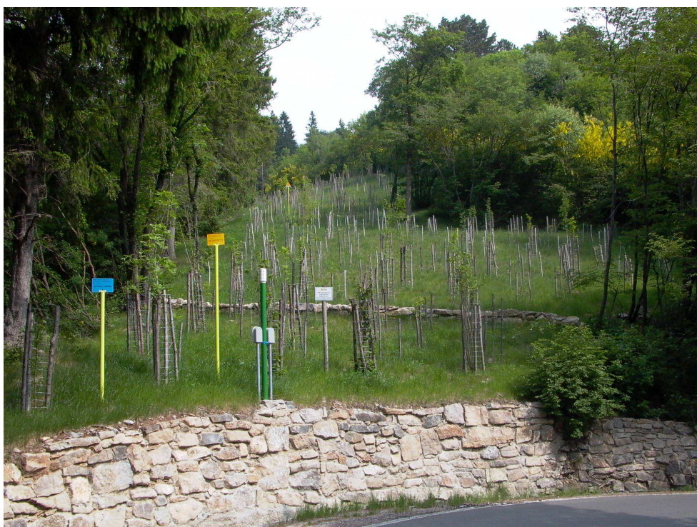
Fig. 2.28 - Ripristino vegetazionale con piantagione diffusa e protezioni individuali. Tubi di sfiato posto in corrispondenza di attraversamento eseguito con tubo di protezione
