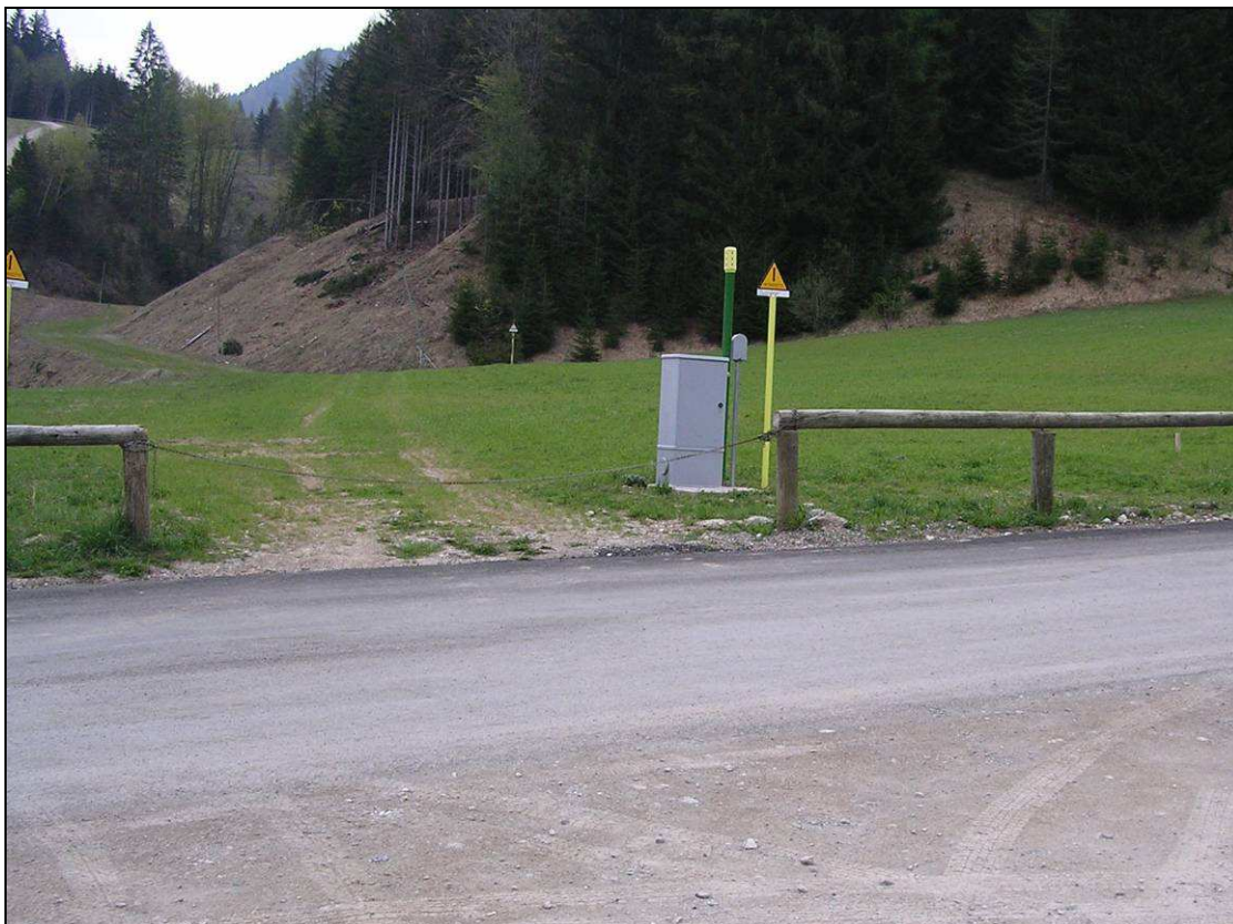
Fig. 2.24 - I cartelli segnalatori del metanodotto ed i tubi di sfiato posti in corrispondenza degli attraversamenti eseguiti con tubo di protezione.
