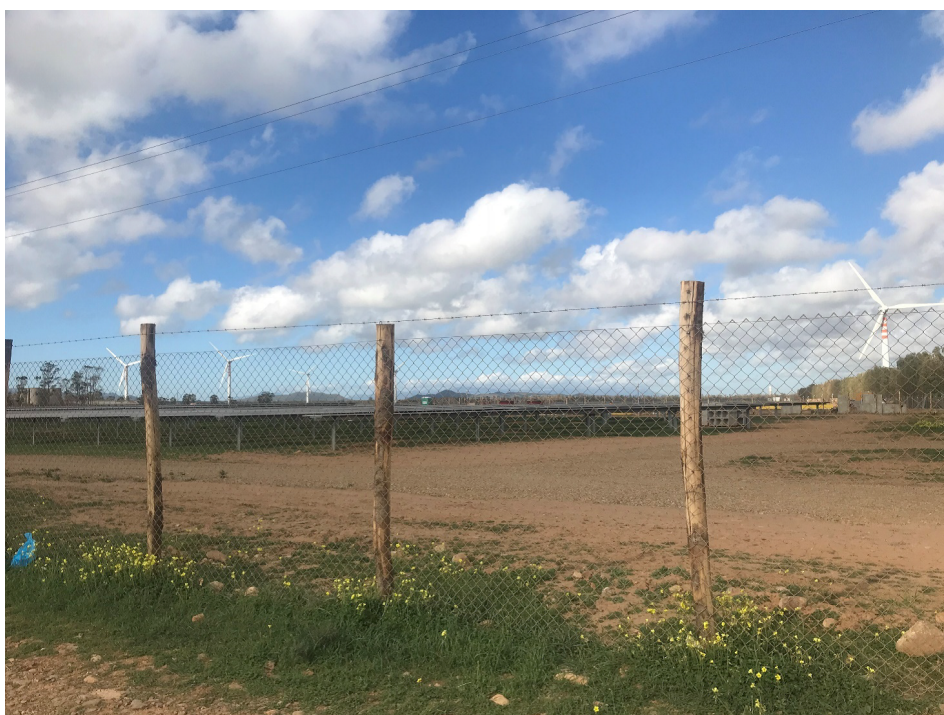
Figure 1-14. Tipologia di recinzione utilizzata
