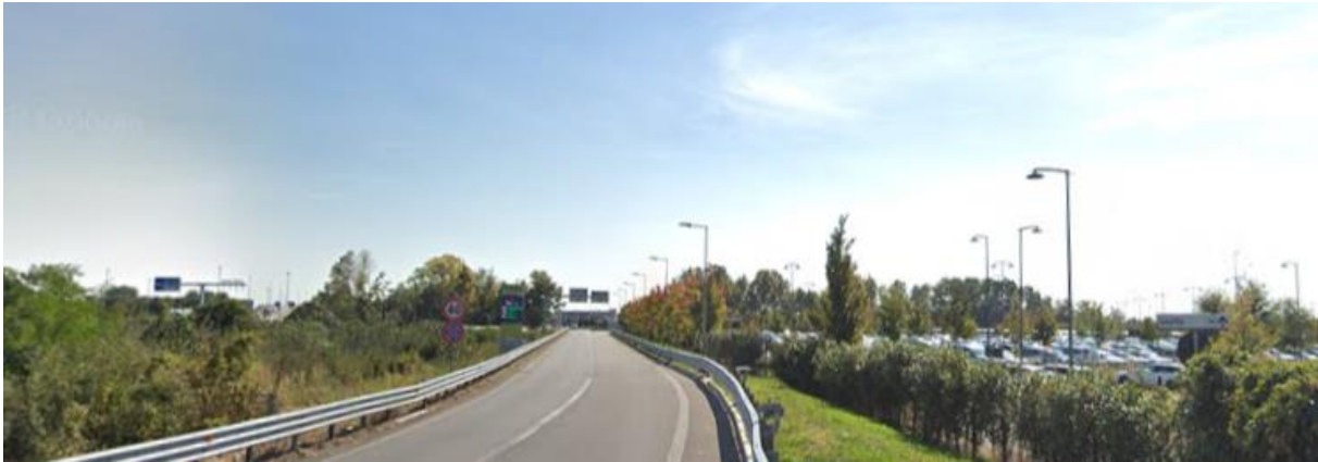
Figura 7-8 Contesto delle aree di cantiere in prossimità dell'area aeroportuale
