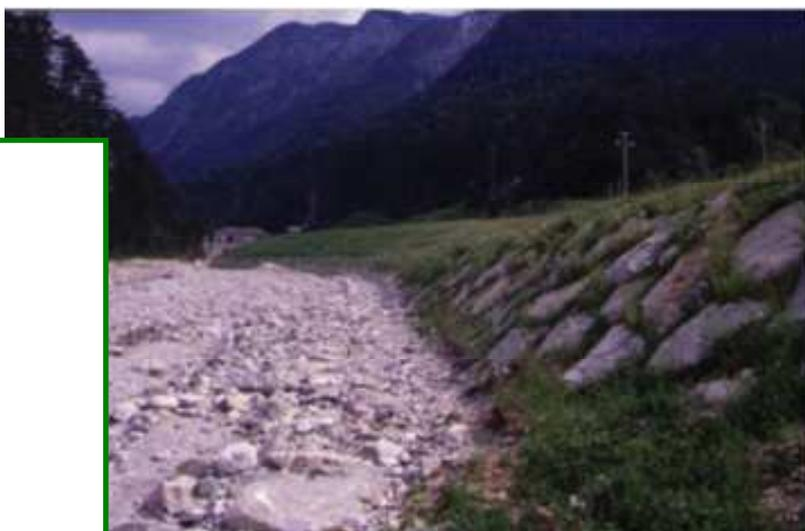
**Fig. 5.3 - Rivestimento spondale con massi.**
