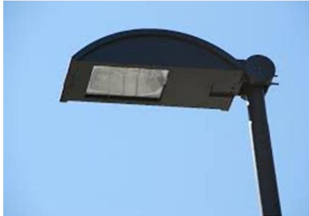
Figura 3.3: Esempio di apparecchio completamente schermato (full-cut-off).
