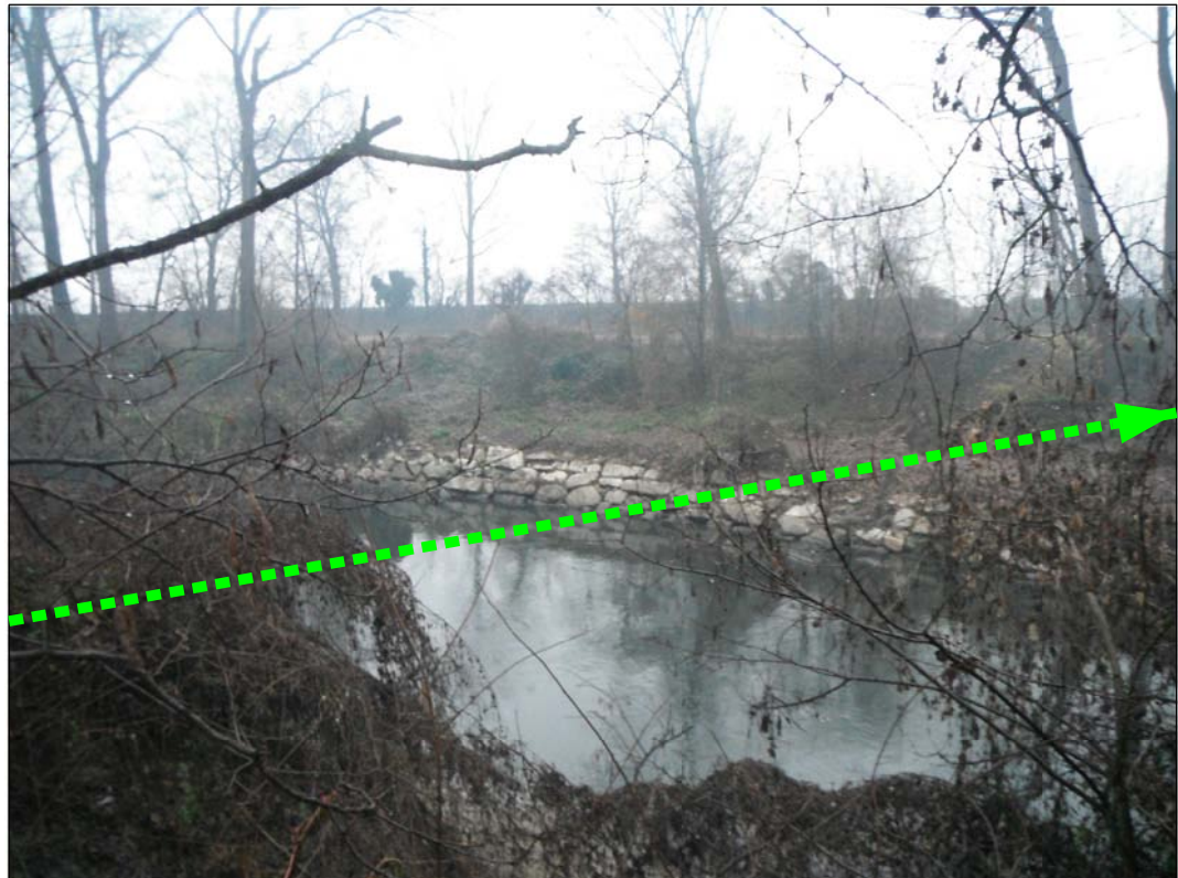
Attraversamento Fiume Lambro Meridionale
