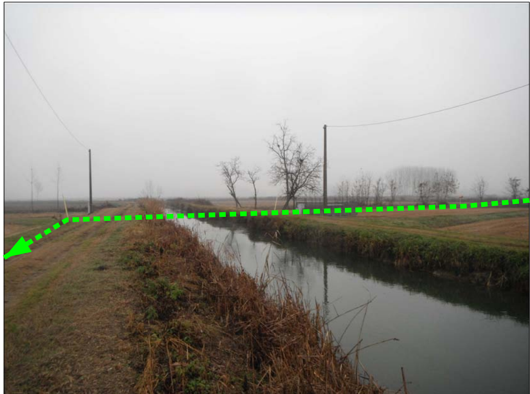
Attraversamento Subdiramatore destro del Canale Cavour
