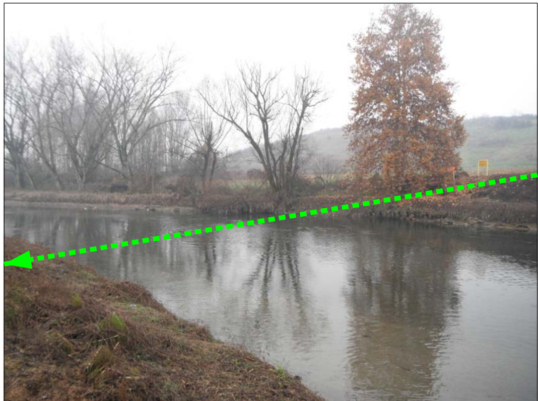
Attraversamento Fiume Lambro
