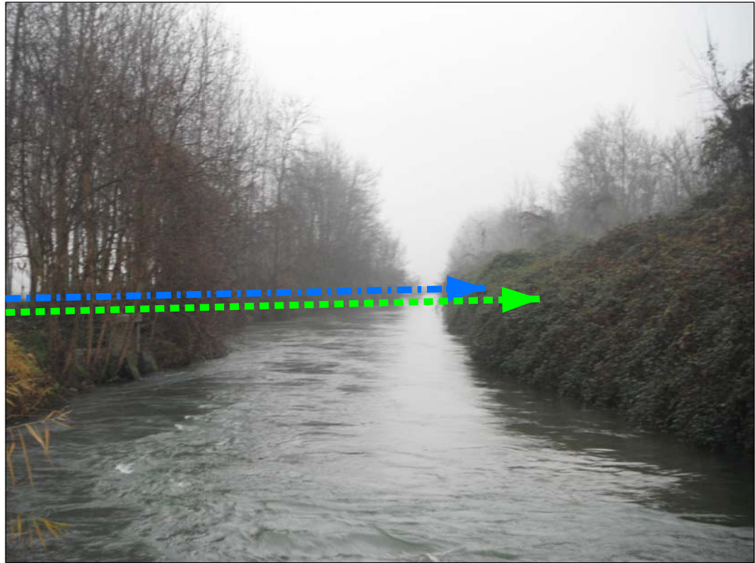
Attraversamento Canale Subdiramatore sinistro del Canale Cavour
