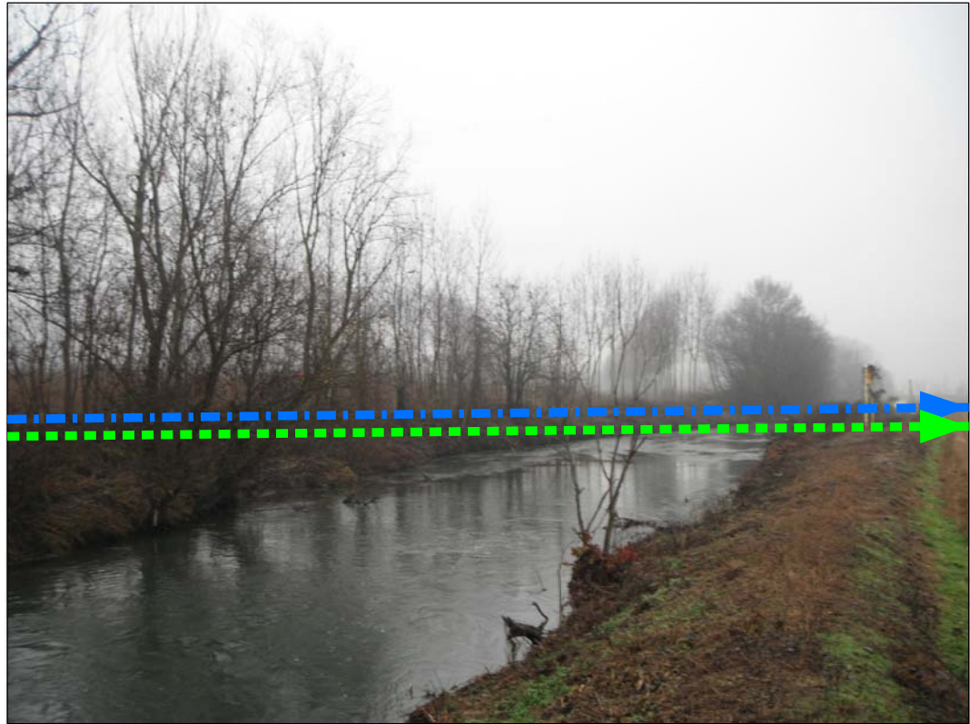
Attraversamento Torrente Terdoppio
