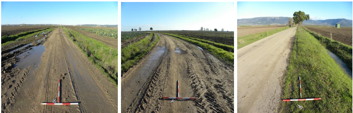
Tratti del Cavidotto interno, A6.
