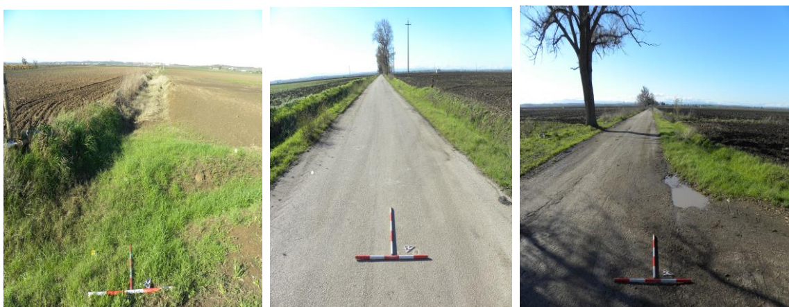
Cavidotto interno verso la torre A3.
