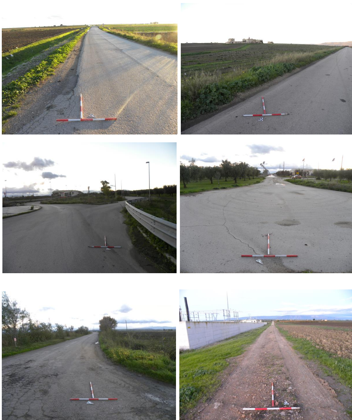
Cavidotto esterno con relativo grado di visibilità.
