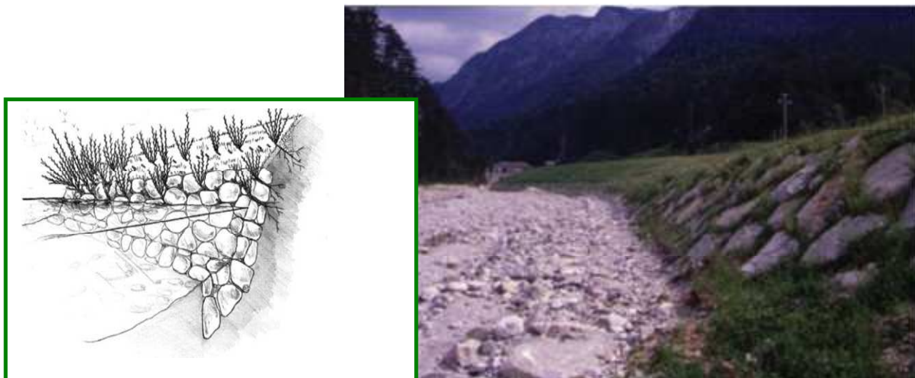
Fig. 4.8 - Rivestimento spondale con massi.
