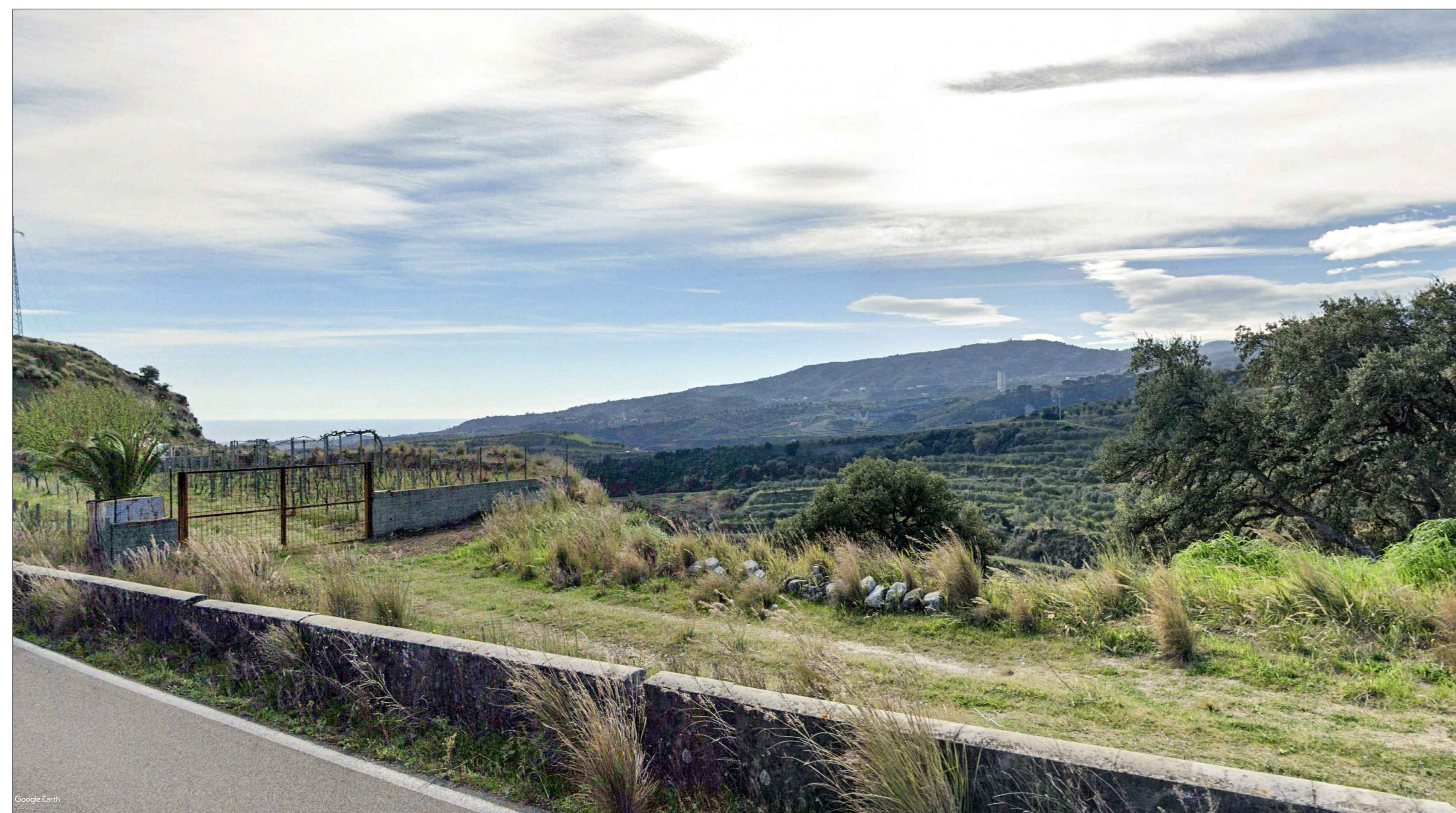
Viadotto VI02 - Vista 4 - Ante operam
