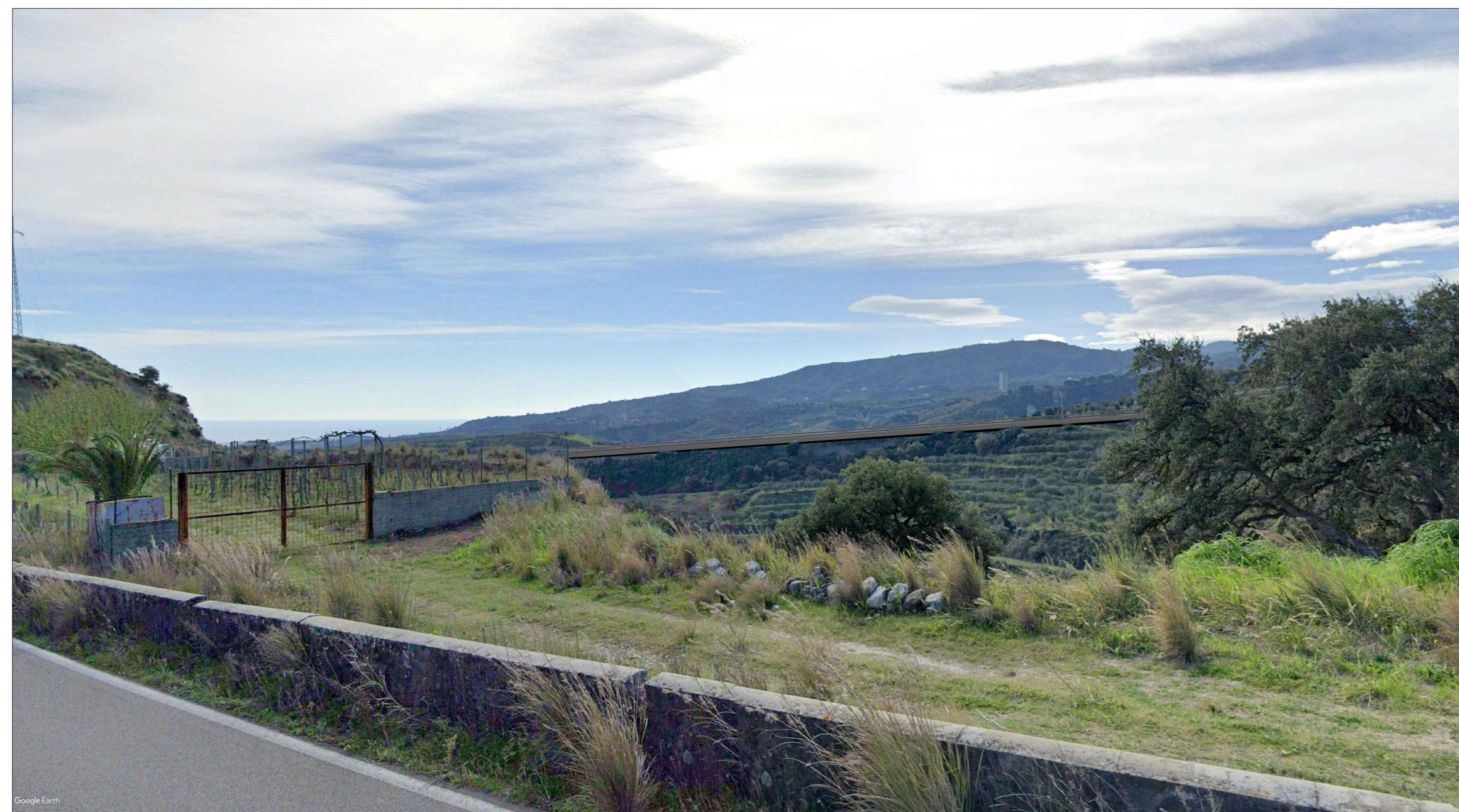
Viadotto VI02 - Vista 4 - Post operam
