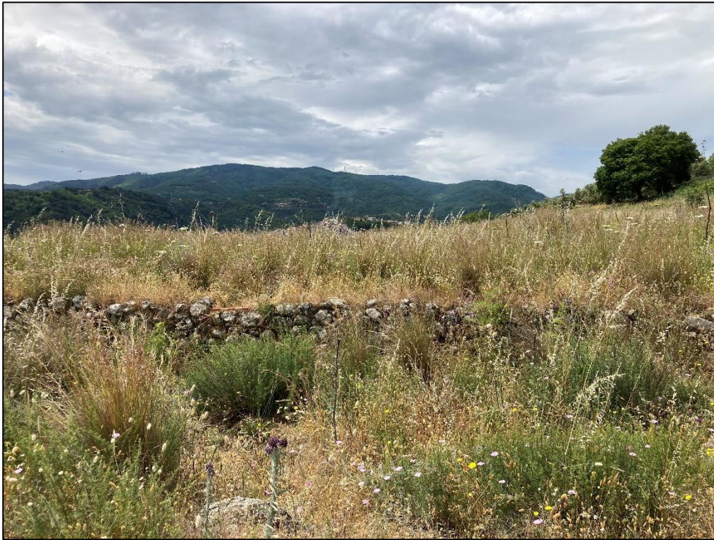
Figura 8. Muro a secco individuato in loc. Gomeno, intercettato dal tracciato in progetto.
