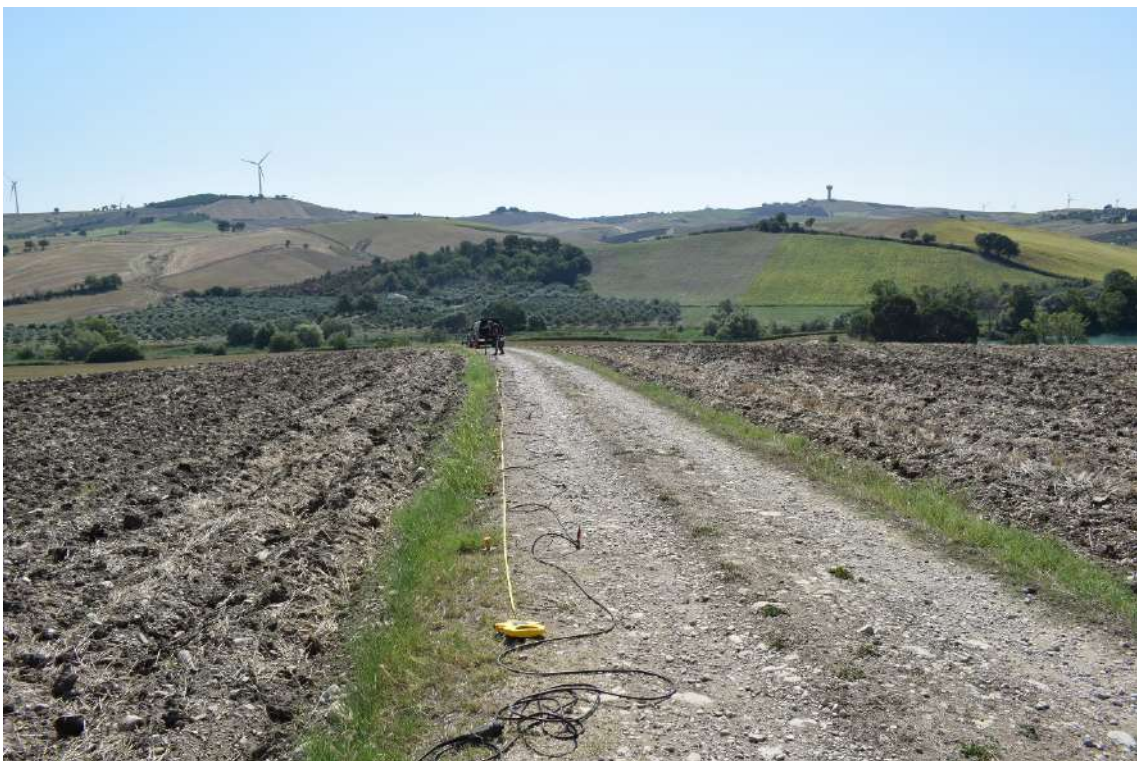
Energizzazione con mazza battente onde longitudinali (onde P)
