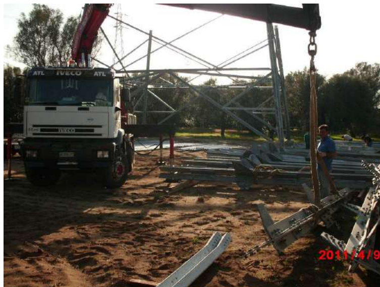
Fasi di montaggio sostegno a traliccio
