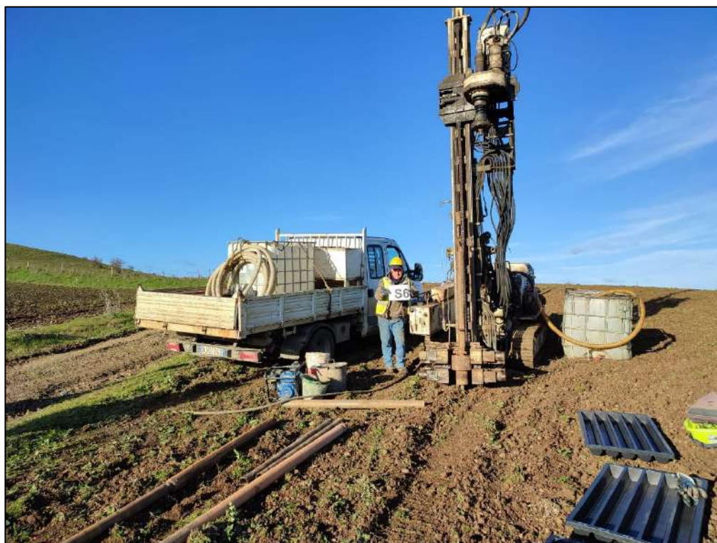
Figura 5. Postazione Sond.6 Sostegno7
