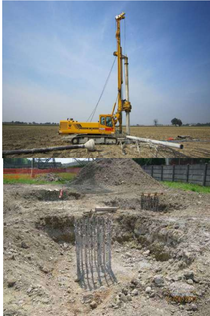
Macchina operatrice per la realizzazione di pali trivellati
