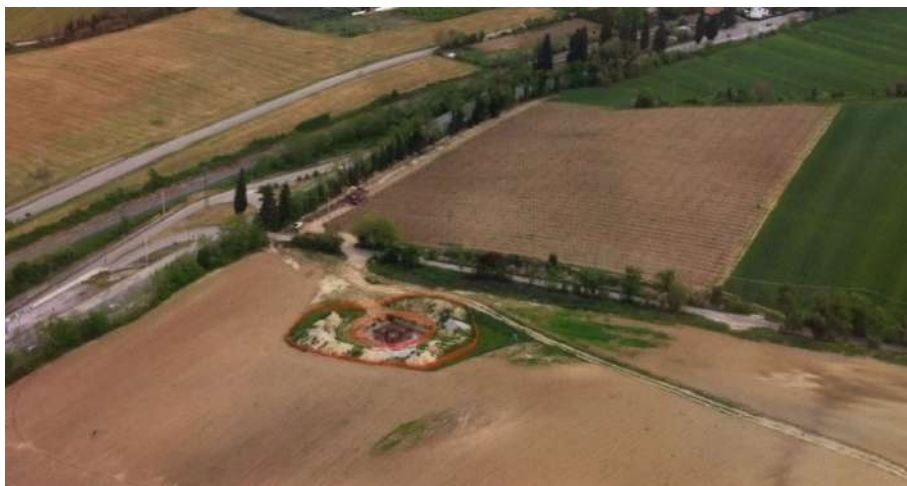
Area sostegno - vista dall'alto dell'estensione complessiva del micro-cantiere
