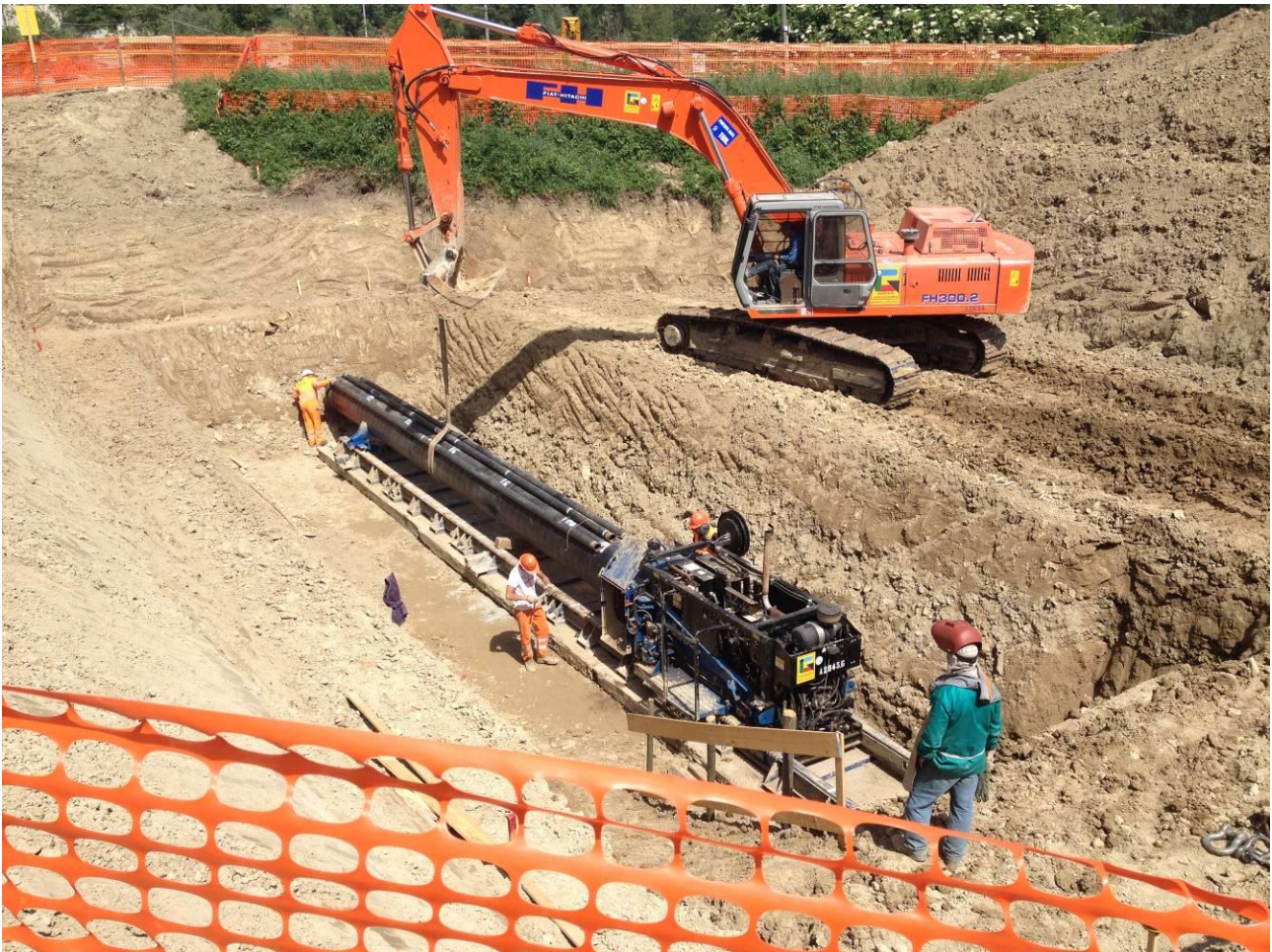
Fig. 3-17: trivella spingitubo.
