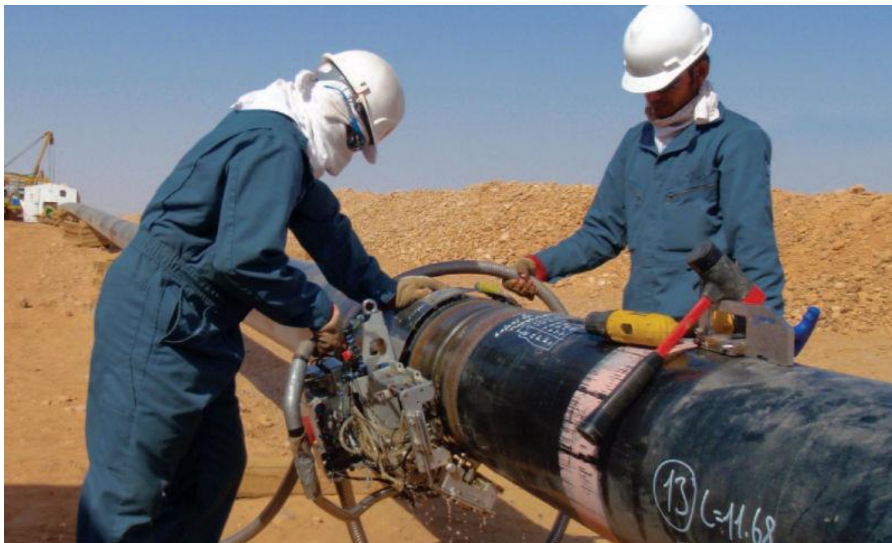
Fig. 3-10: Saldatura.
