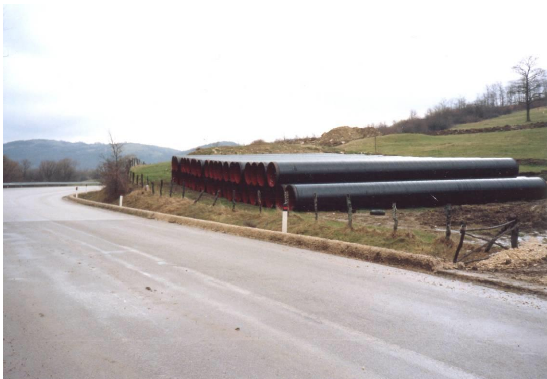
Fig. 3-7: Piazzole di accatastamento tubazioni.
