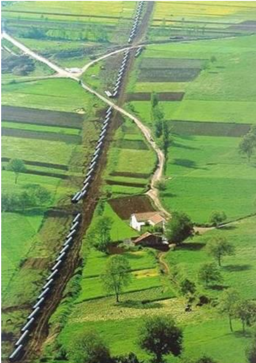
Fig. 3-9: Sfilamento dei tubi lungo la linea.
