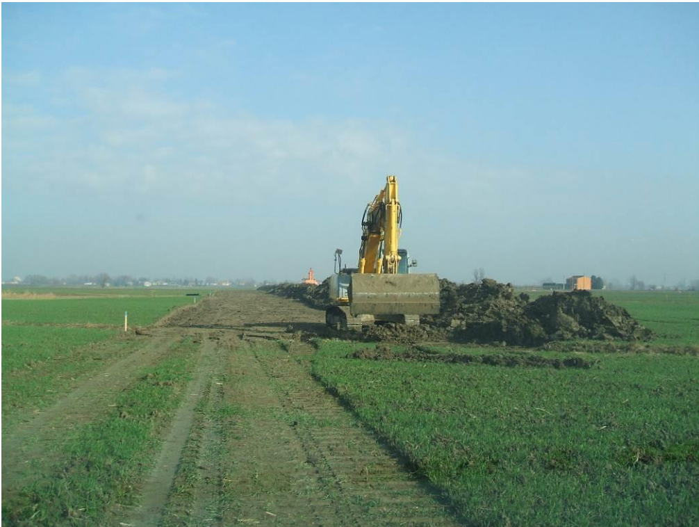
Fig. 3-8- Apertura area di passaggio in area agricola
