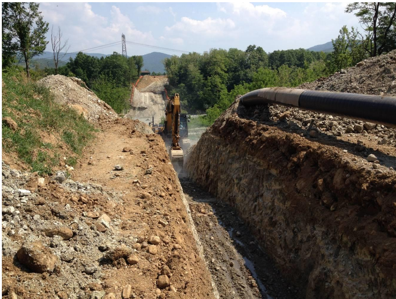
Fig. 3-11: Scavo per l'alloggiamento della condotta.
