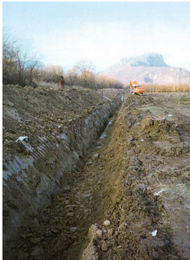
Fig. 3-13: Operazione di rinterro della condotta.
