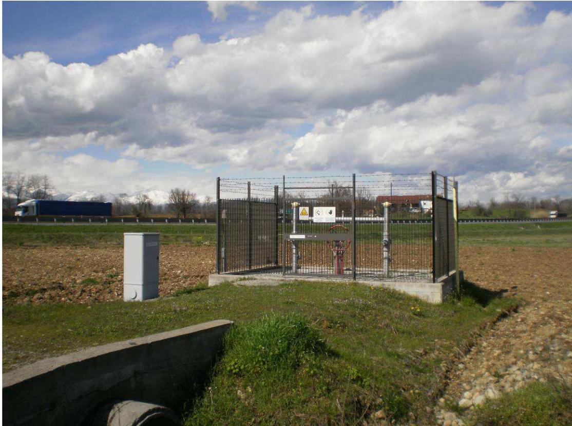
**Fig. 2.22 - Esempio di impianto di intercettazione di linea PIL.**
