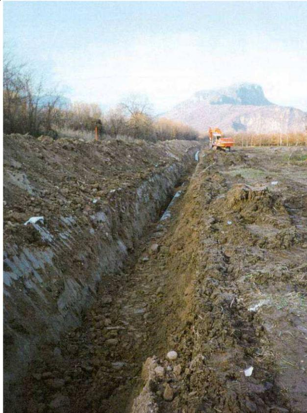
**Fig. 2.10 - Operazione di rinterro della condotta.**
