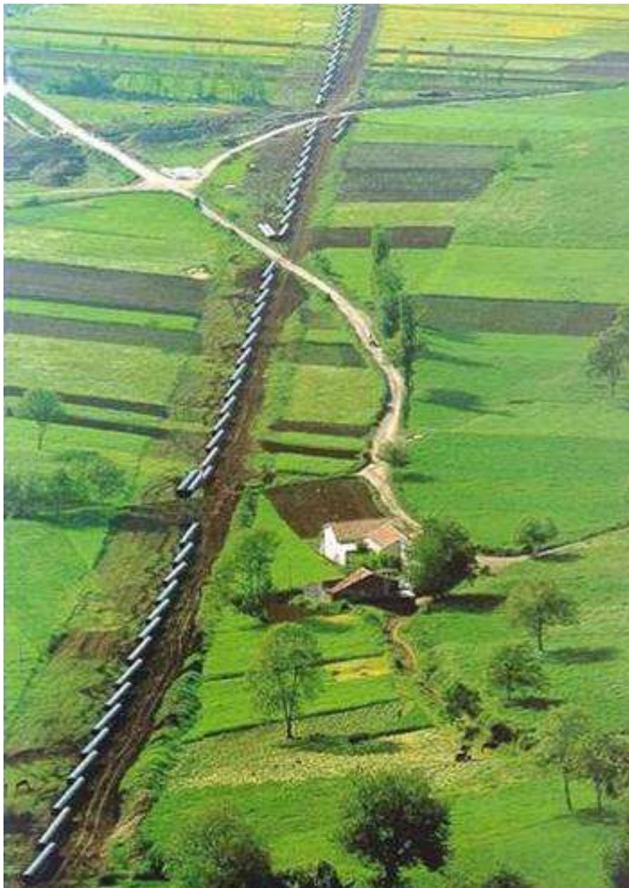
**Fig. 2.6 - Sfilamento dei tubi lungo la linea.**
