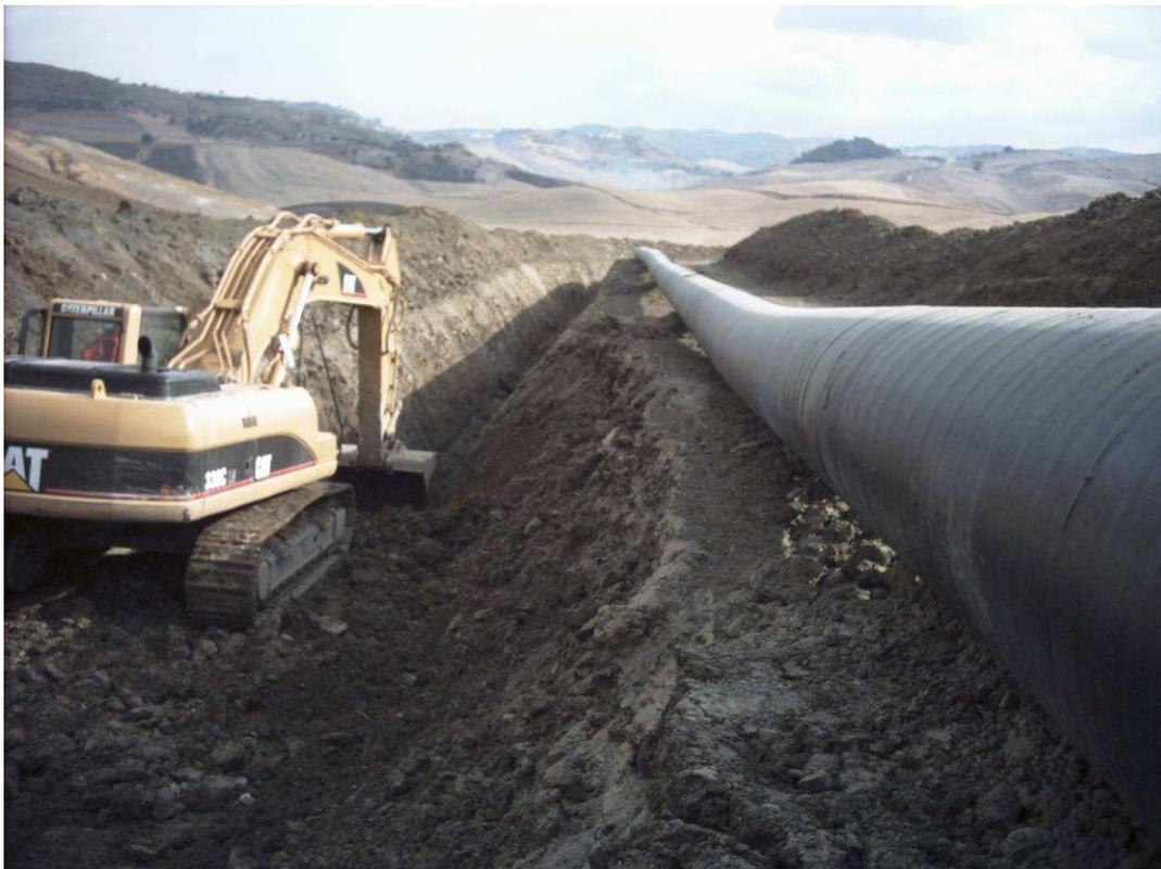
**Fig. 2.8 - Scavo per l'alloggiamento della condotta.**
