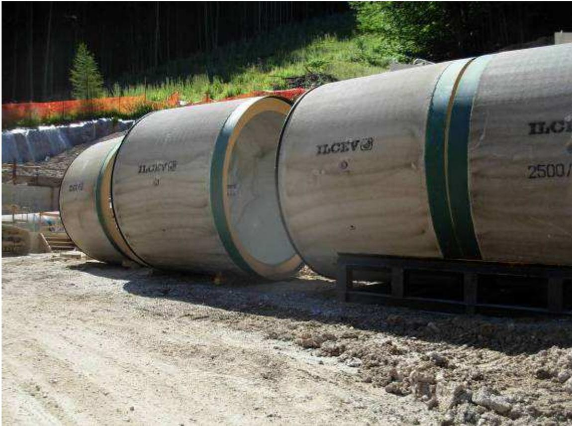
**Fig. 2.19 - Stoccaggio tubi in c.a.**
