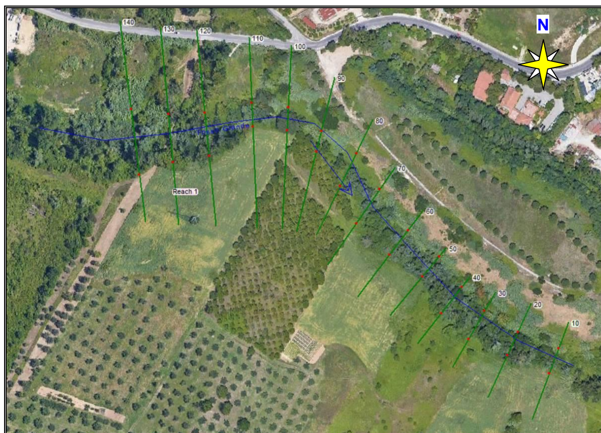
Fig.5.2/B: Modellazione geometrica in Hec Ras (RS140 a monte e RS10 a valle)
