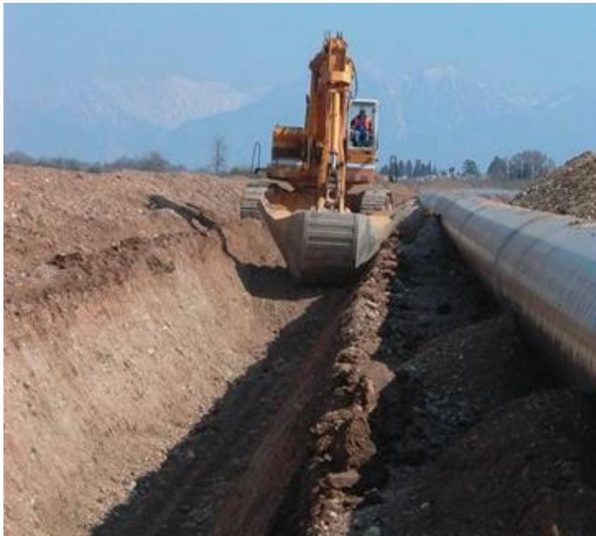
**Fig. 7.3 - Scavo per l'alloggiamento della condotta**
