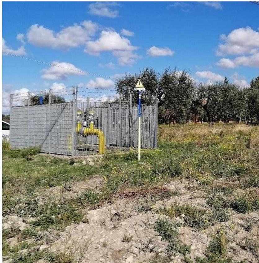
**Fig. 7.8 - Esempio di impianto di intercettazione di linea (P.I.L.)**
