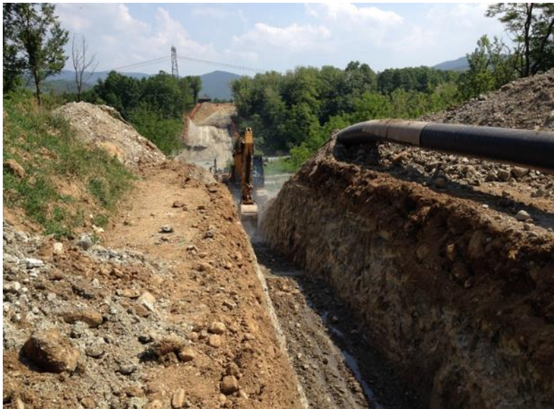
Fig. 2.2 - Scavo per l'alloggiamento della condotta.
