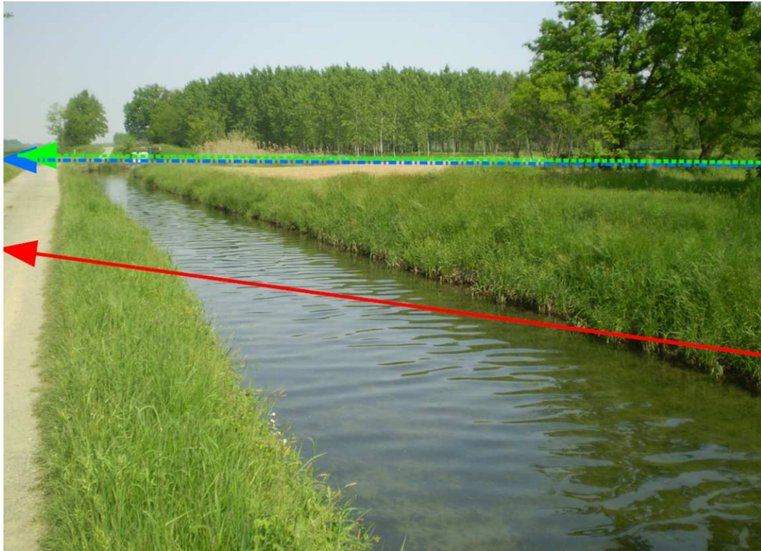
Fig. 3.12 - Attraversamento del naviglio di Bereguardo al km 39+175.
