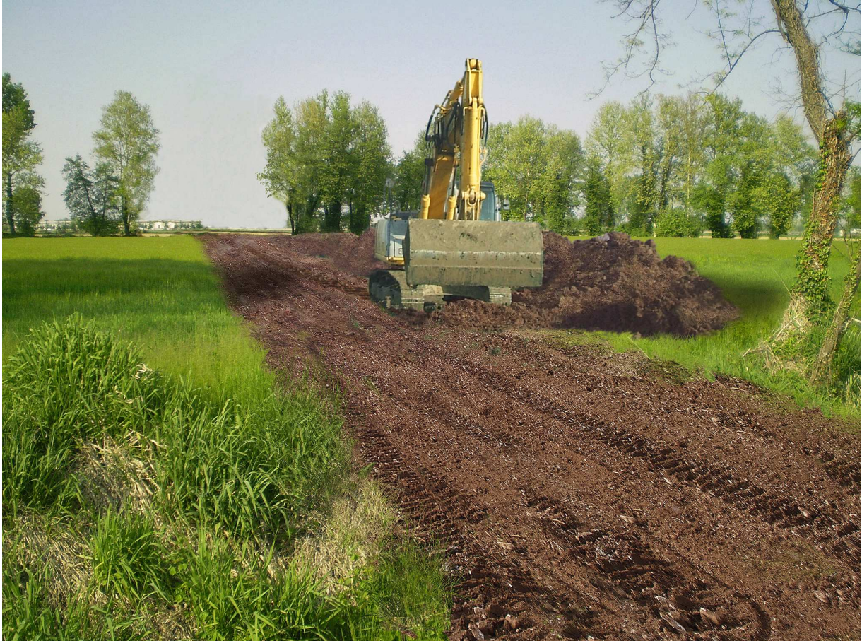
Fig. 3.20 - apertura dell'area di passaggio. Può essere possibile l'abbattimento di alcuni esemplari arborei od arbustivi lungo i filarie e le siepi.
