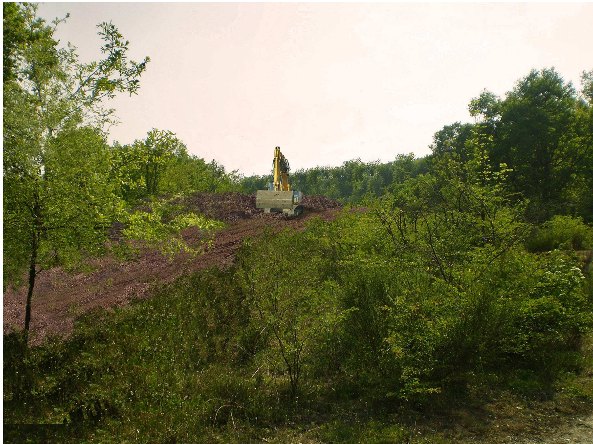
Fig. 3.24 - apertura dell'area di passaggio ridotta all'interno del bosco.
