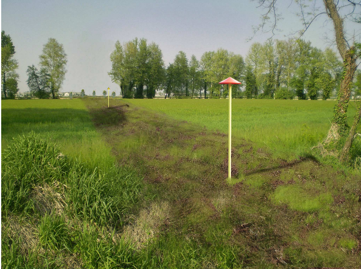
Fig. 3.21 - Termine dei lavori lungo l'area di passaggio. Si può notare sullo sfondo l'avvenuta piantumazione di specie arboree allo scopo di ripristinare la continuità del filare.
