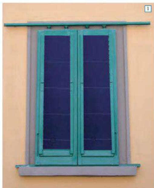
Fig 1 - Prototipo Persiana solare
