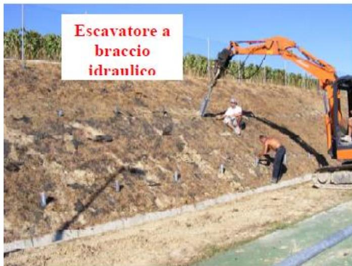
**Figura 1 – Esempio di posa delle strutture portanti su pendenze accentuate.**
