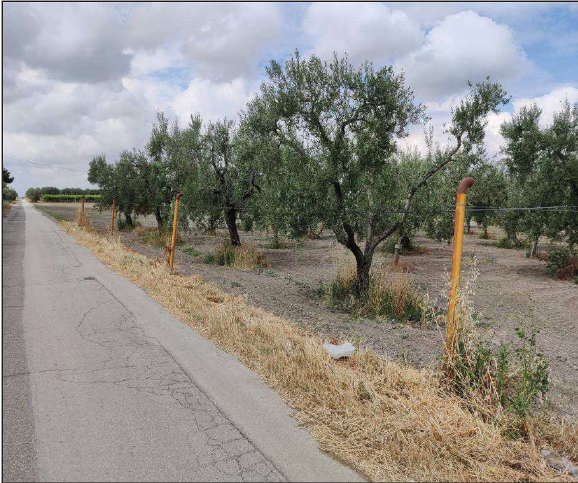
Foto n. 2 – intersezione reticolo/cavidotto su via “Le Vigne”
