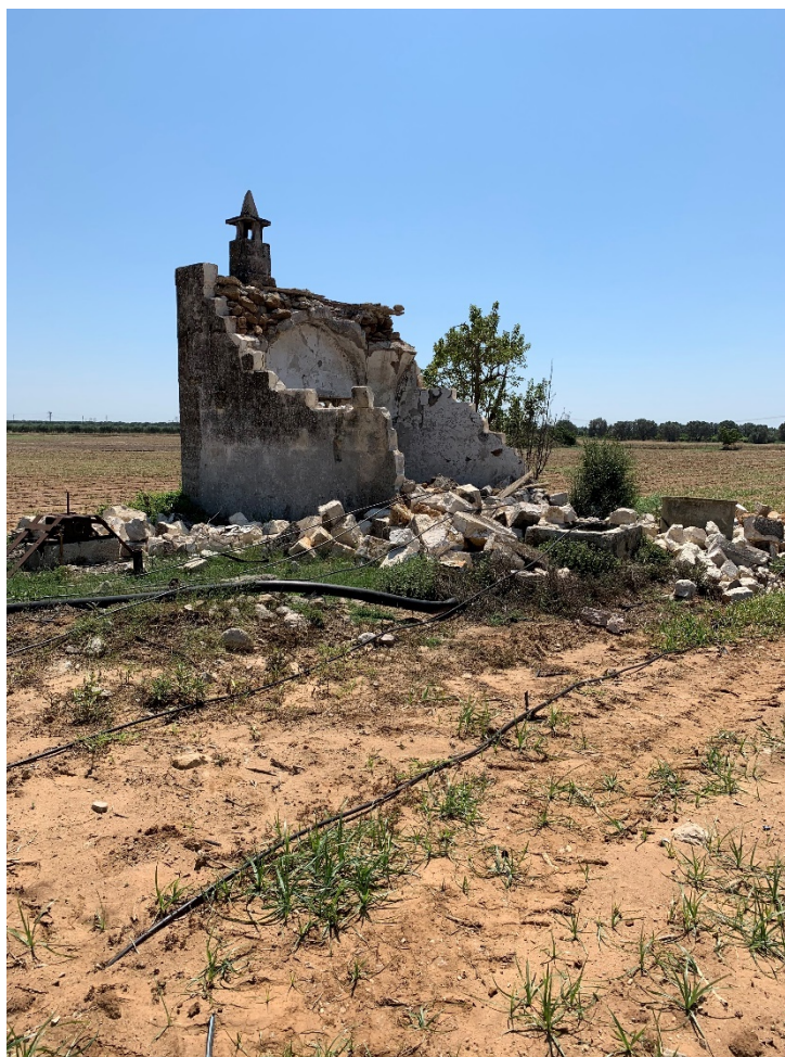
Figura 29: Unità crollante presente nell'area di impianto
