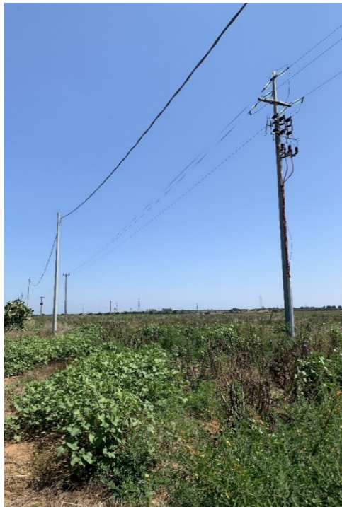
Figura 27: Linee aeree BT (a sinistra) e MT (a destra).
