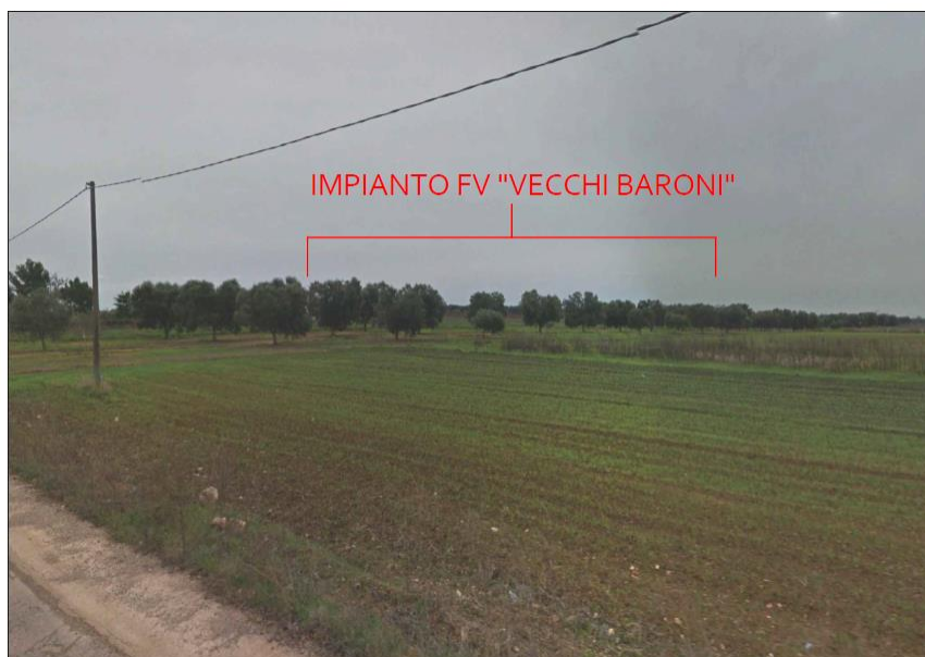
Figura 11: Vista prospettica dell'impianto da Masseria Vaccaro
