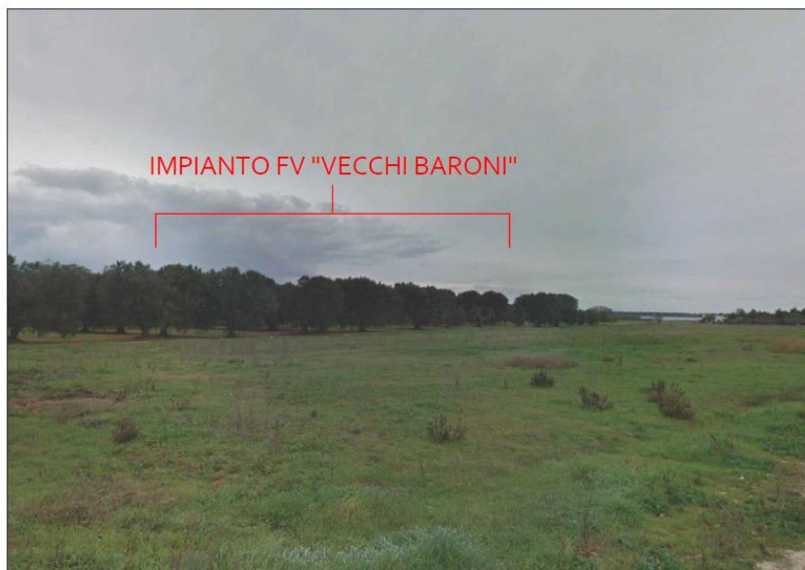
Figura 7: Vista prospettica dell'impianto da Masseria Buffi.
