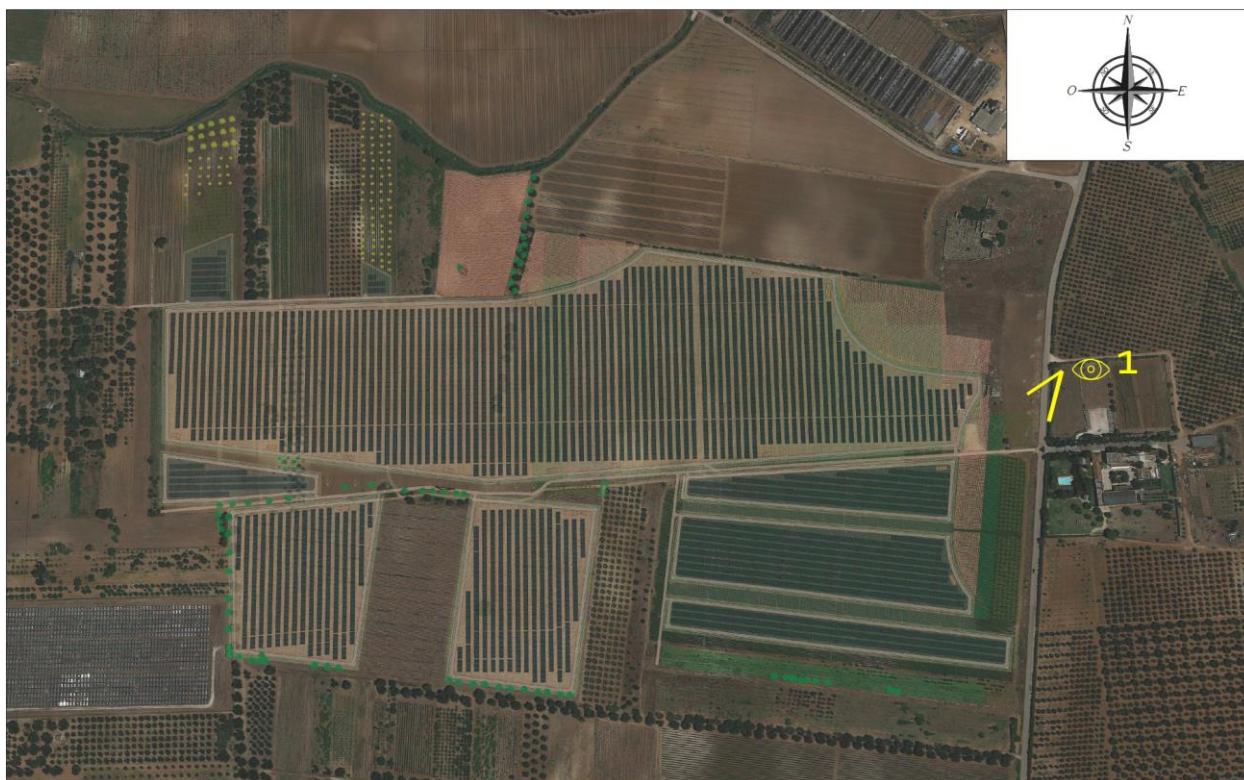
Figura 97: Ubicazione dei punti in cui sono state scattate le foto per le simulazioni (Punti 1, indicati in giallo)
