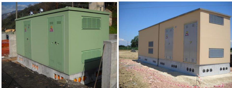
Figura 49: esempio di cabinati
