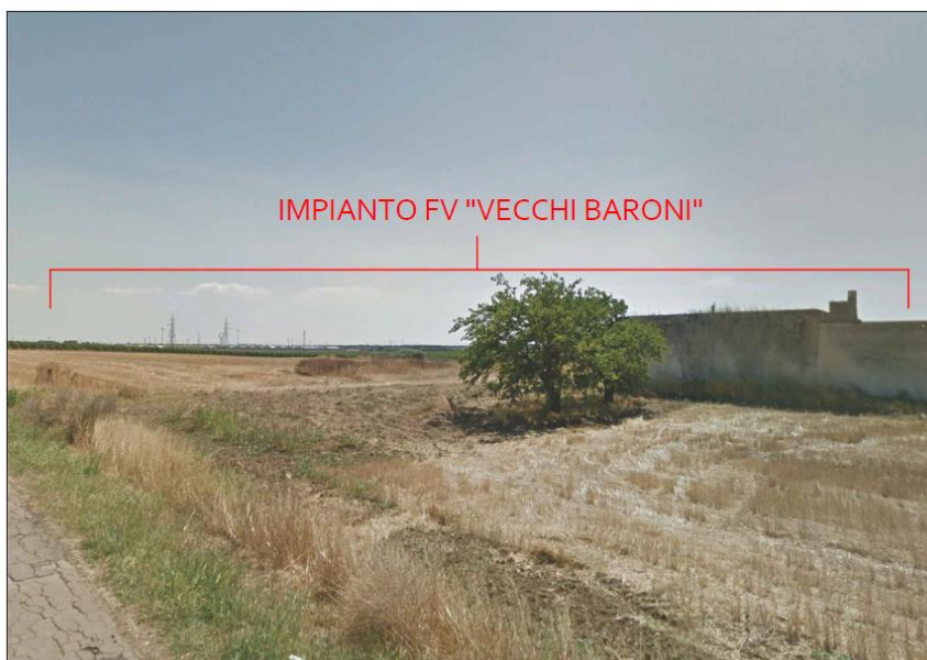
Figura 93: Vista prospettica dell'impianto da Masseria Vecchi Baroni
