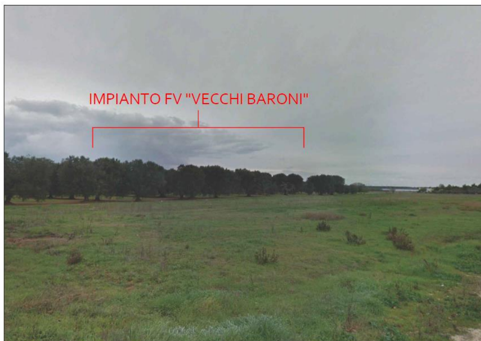
Figura 29: Vista prospettica dell'impianto da Masseria Bufi.
