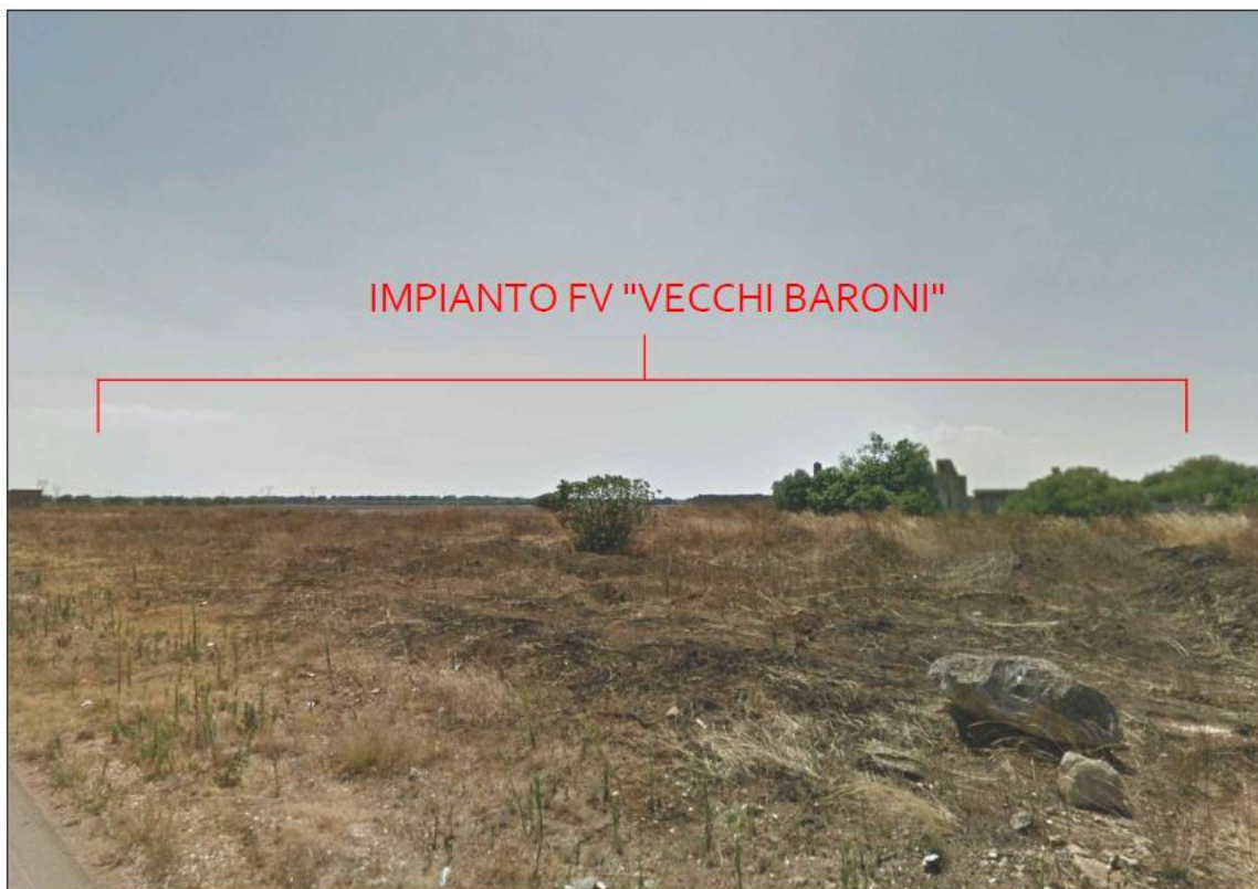
Figura 33: Vista prospettica dell'impianto da Masseria Baroni
