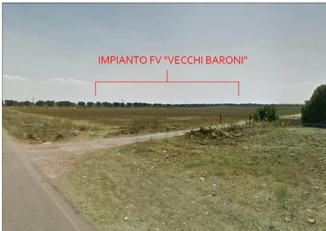
Figura 37: Vista prospettica dell'impianto da Masseria Baroni Nuova
