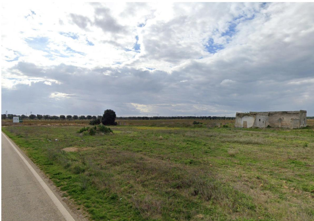
Figura 45: Vista dal punto 1 posto sulla S.P. 44 "Acquaro" – situazione ante operam
