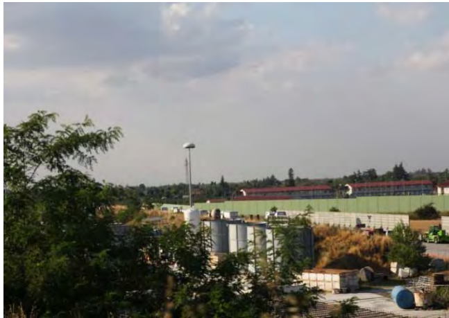
Cantieri in Strada della Tuara
