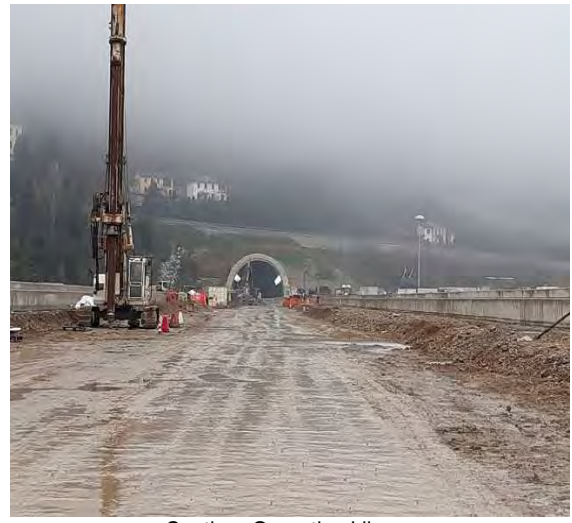
Cantiere Operativo Libarna
