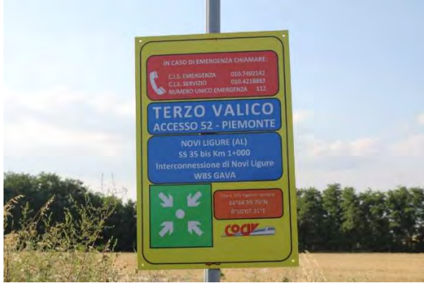
Cantiere Novi Ligure
