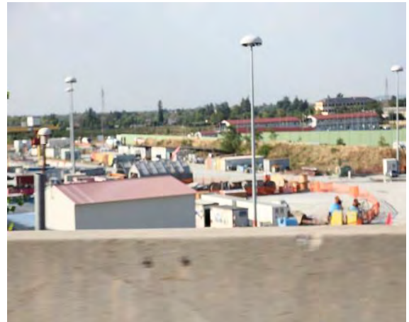
Cantieri in Strada della Tuara
