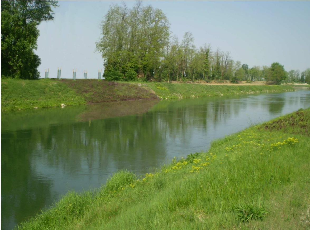
**Foto 36 - termine dei lavori a ridosso del Canale ed esecuzione dei ripristini (inerbimenti e piantumazioni). Si prevede inoltre la riprofilatura delle sponde.**
