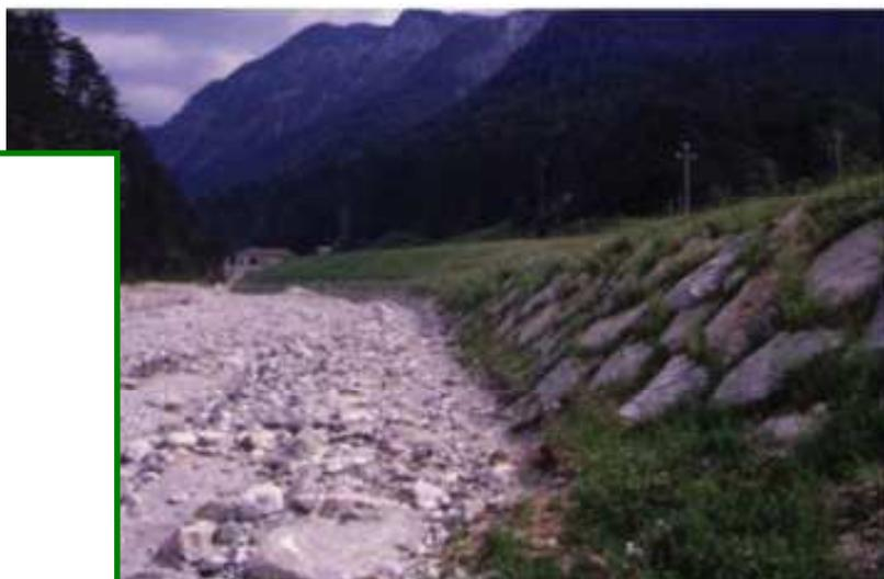
**Fig. 6.3 - Rivestimento spondale con massi.**
