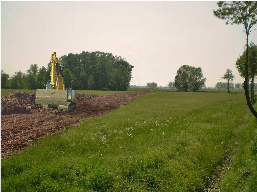
**Foto 31 - apertura dell'area di passaggio di larghezza 14 m. Come conseguenza verranno abbattute alcune piante presenti lungo il filare.**
