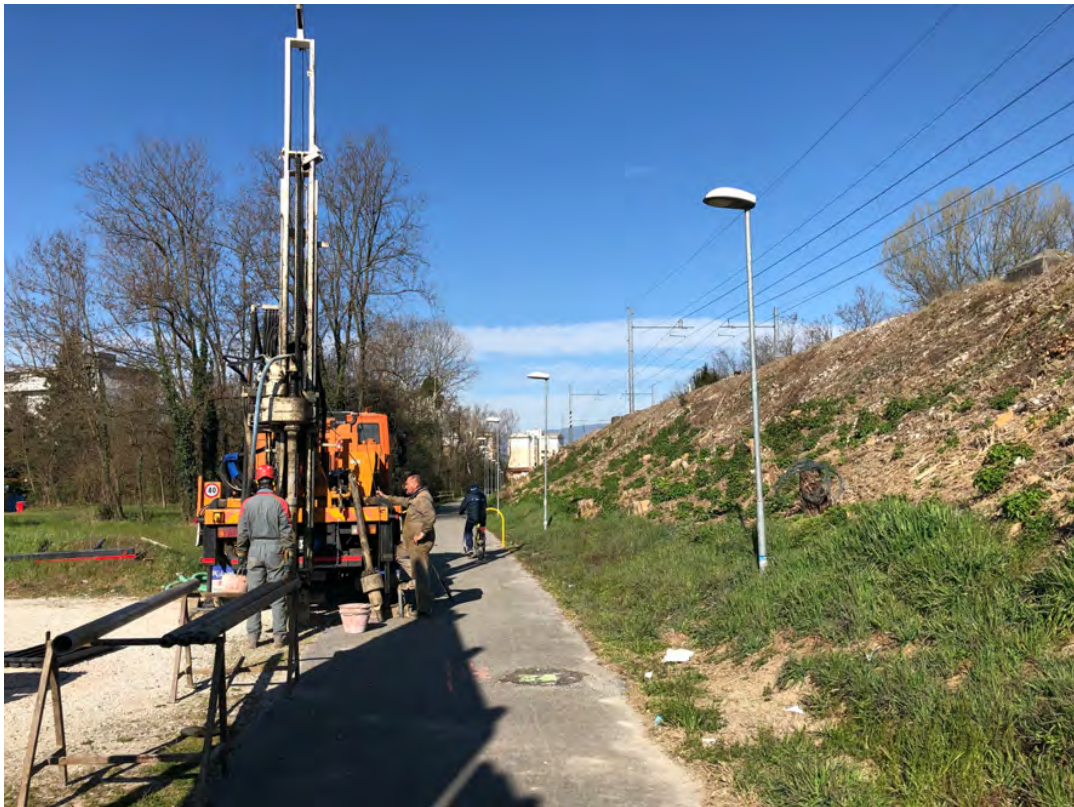
Sondaggio N° 1 postazione delle attrezzature
