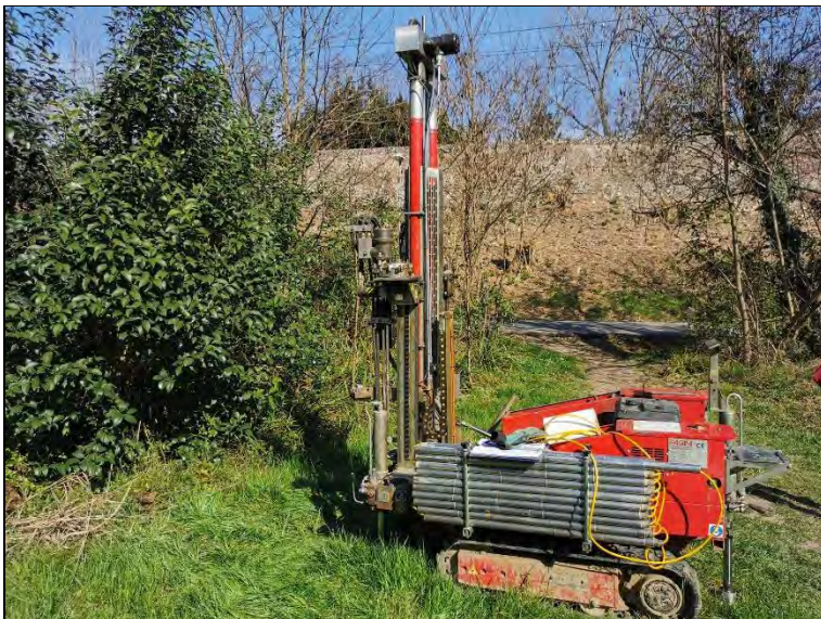
Esecuzione prova DPSH5
