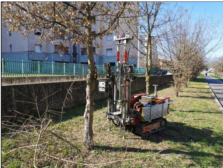
Esecuzione prova DPSH3
