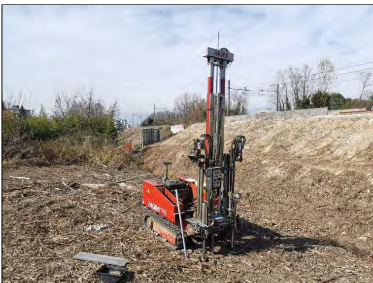
Esecuzione prova DPSH6
