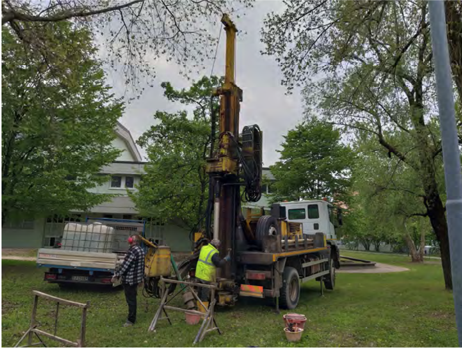
Sondaggio S3, postazione delle attrezzature
