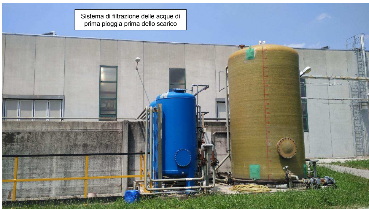
Figura 6-5. Vasca di prima pioggia – Sistema di filtrazione finale prima dello scarico
