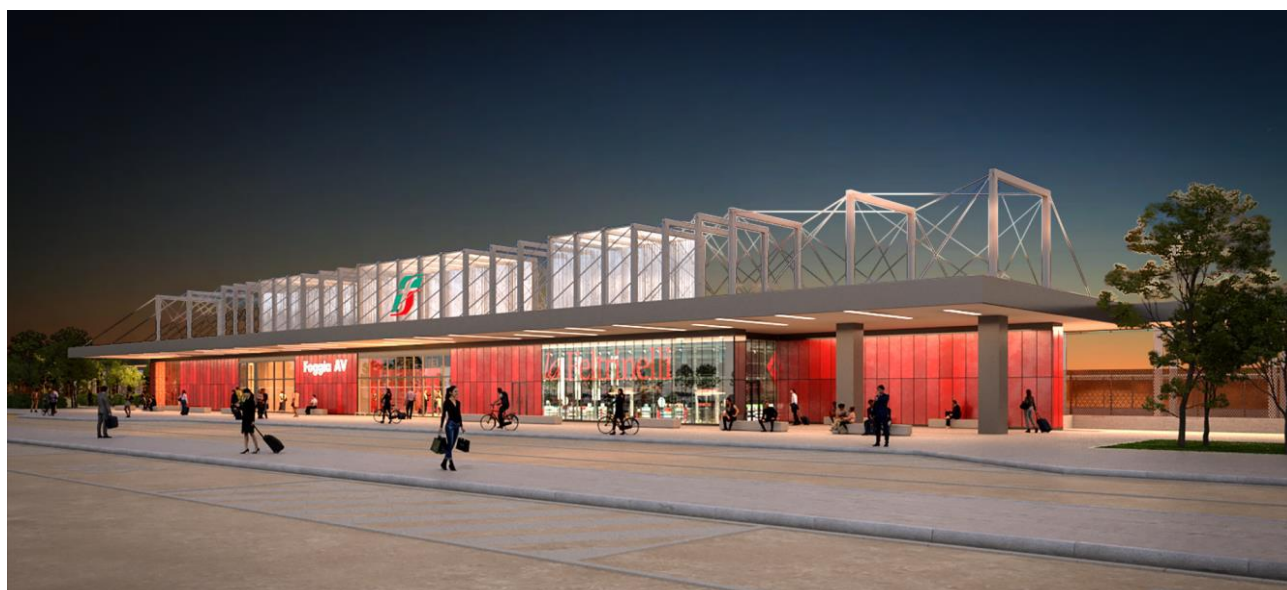
Figura 20 – Rendering della vista notturna della fermata AV, con la grande pensilina metallica strallata e l'effetto lucernario/lanterna
