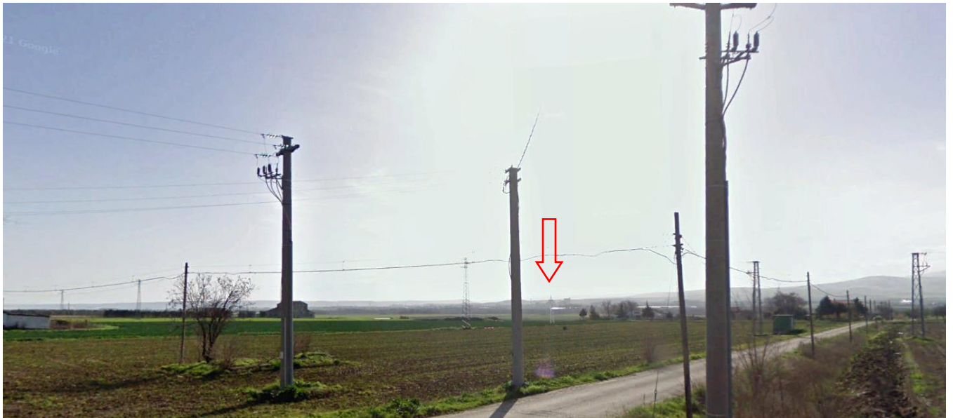
Punto di vista 4, lungo la strada provinciale n.91, post operam. (Parco regionale)
