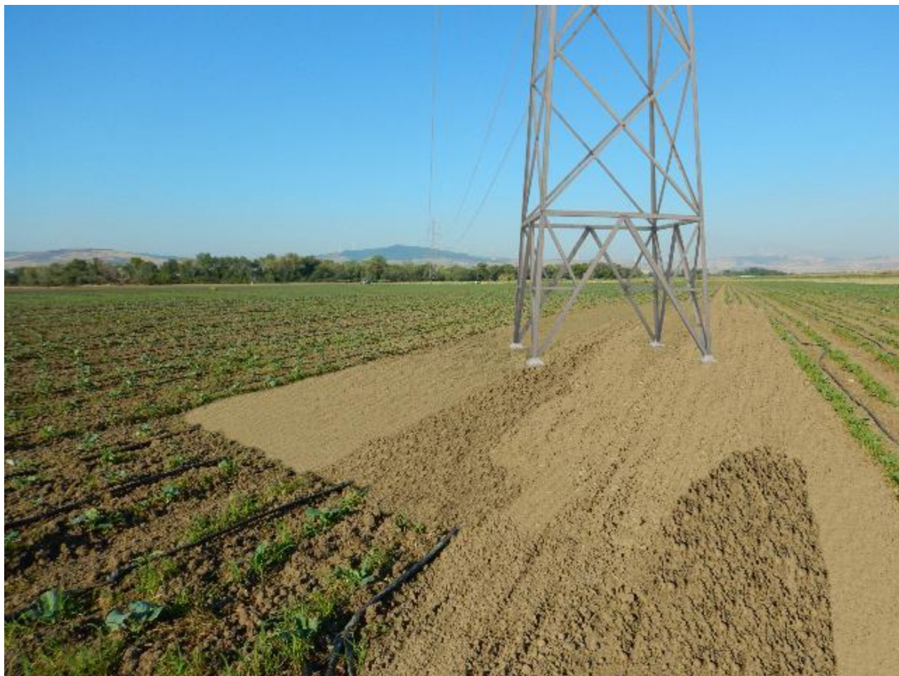
Punto di vista 5, lungo viabilità podereale in distacco da strada provinciale n.91, post operam. (attraversamento F. Ofanto)
