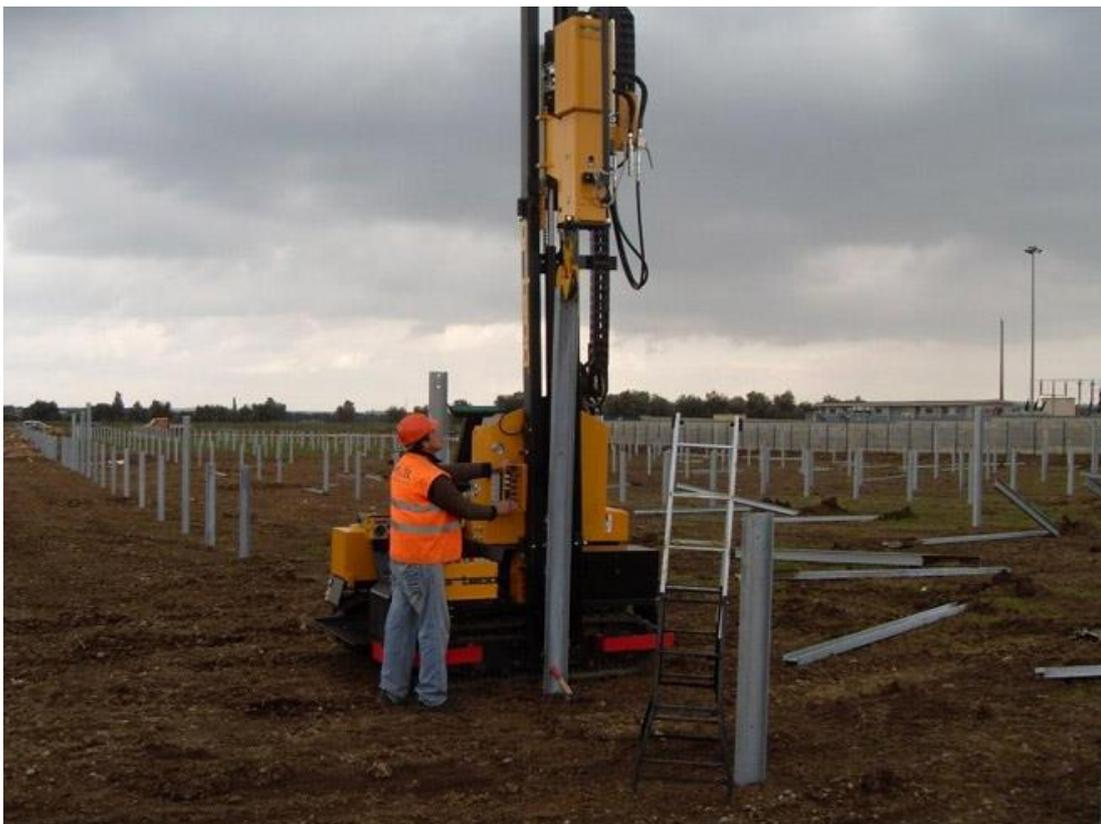
Fig.°24 Operazione di rimozione dei pali infissi
