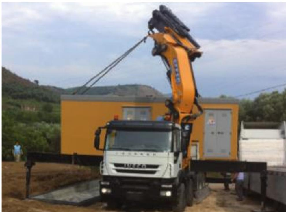
Fig. 25 Operazione di rimozione delle cabine prefabbricate
