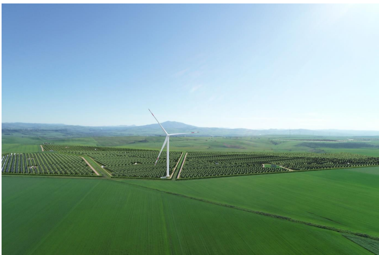
Figura 5-8: Altra vista d'insieme impianti fotovoltaici ed eolici esistenti, autorizzati o in valutazione – Blocco B
