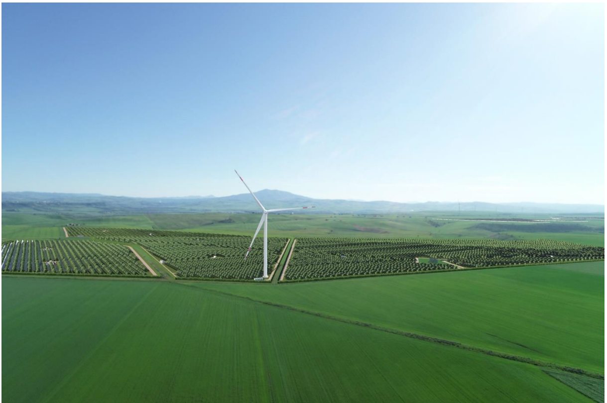
Figura 4-23: Altra vista d'insieme impianti fotovoltaici ed eolici esistenti, autorizzati o in valutazione – Blocco B
