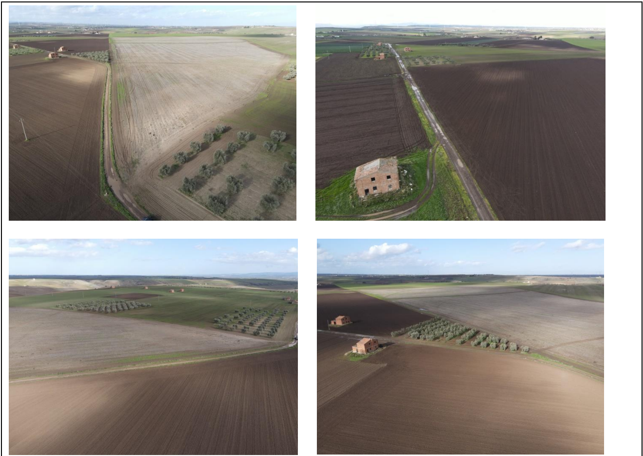
Figura 1-21: Quattro vedute da drone del sito di intervento Blocco A
