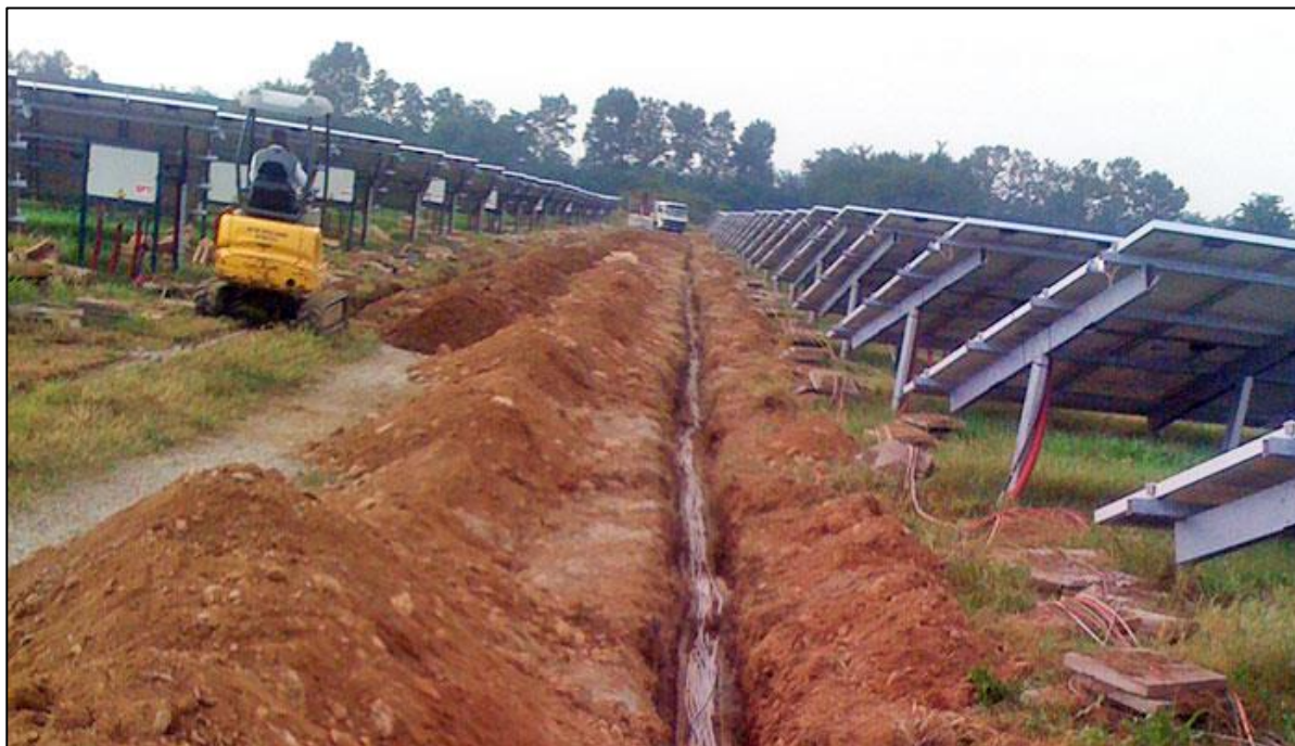
Figura 17 – Tipico di scavo per cavi bt/MT
