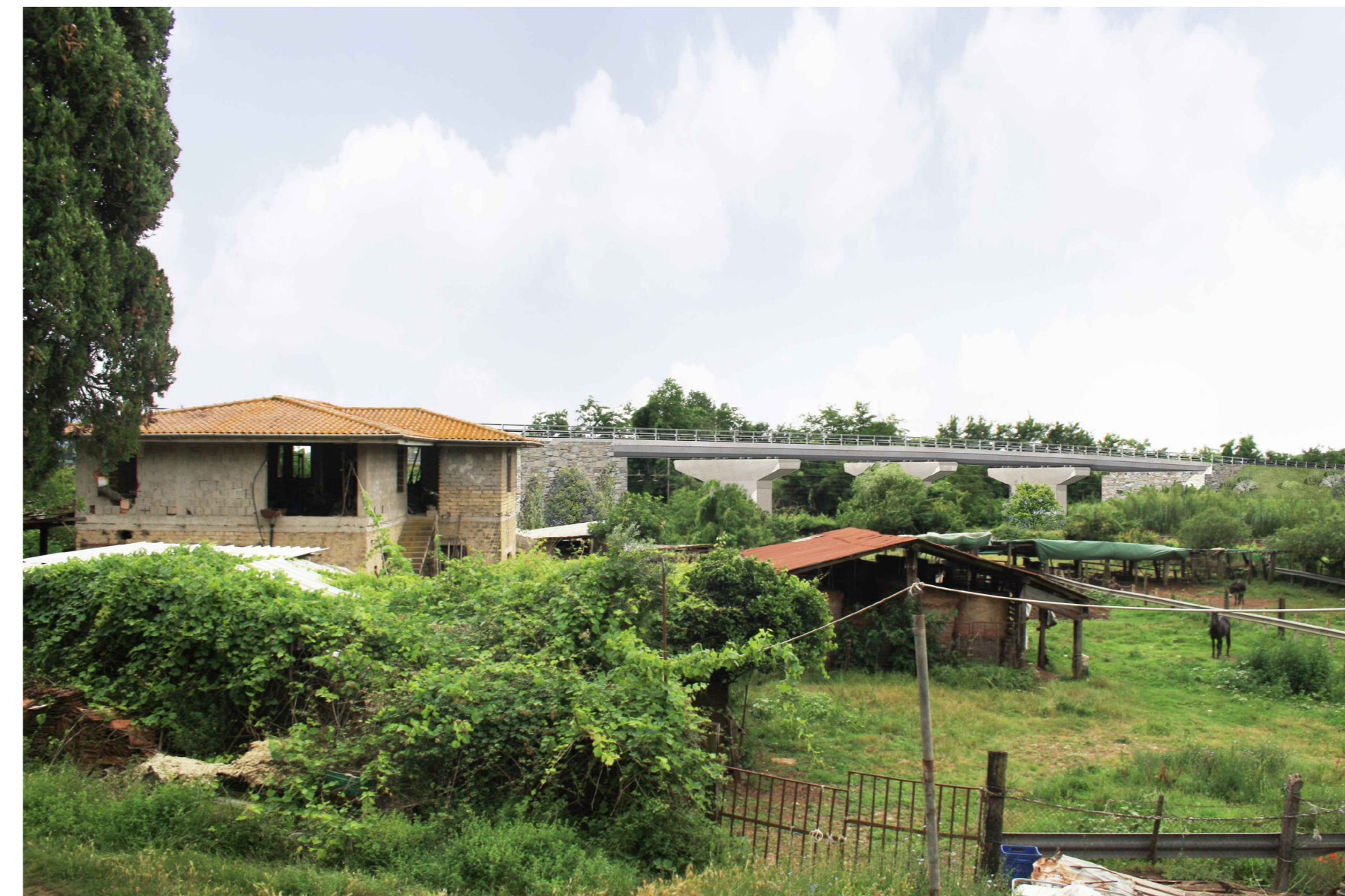
Fotoinserimento n.2 - Post operam - Conparamento murario in pietra
