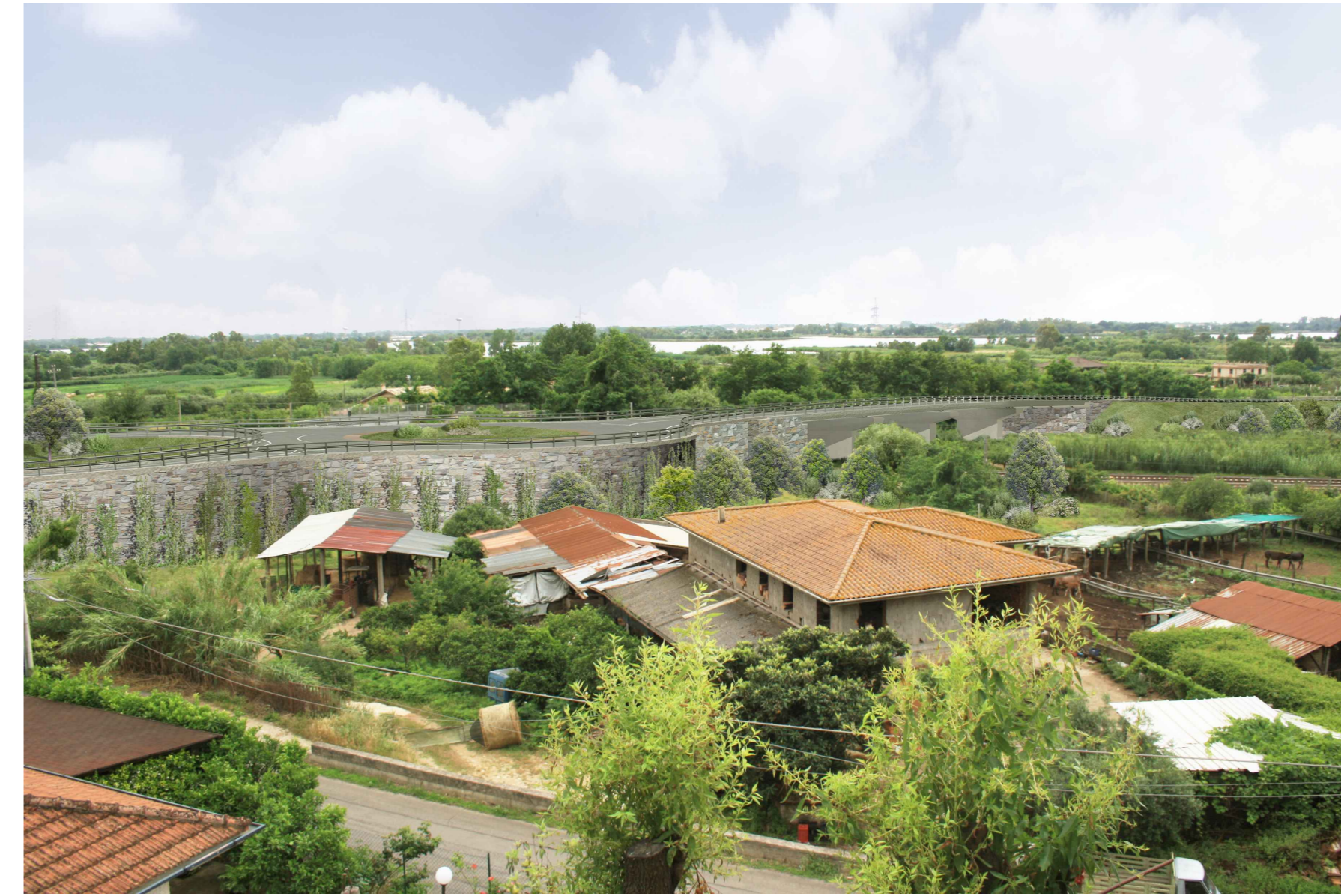
Fotoinserimento n.1 - Post operam - Conparamento murario in pietra
