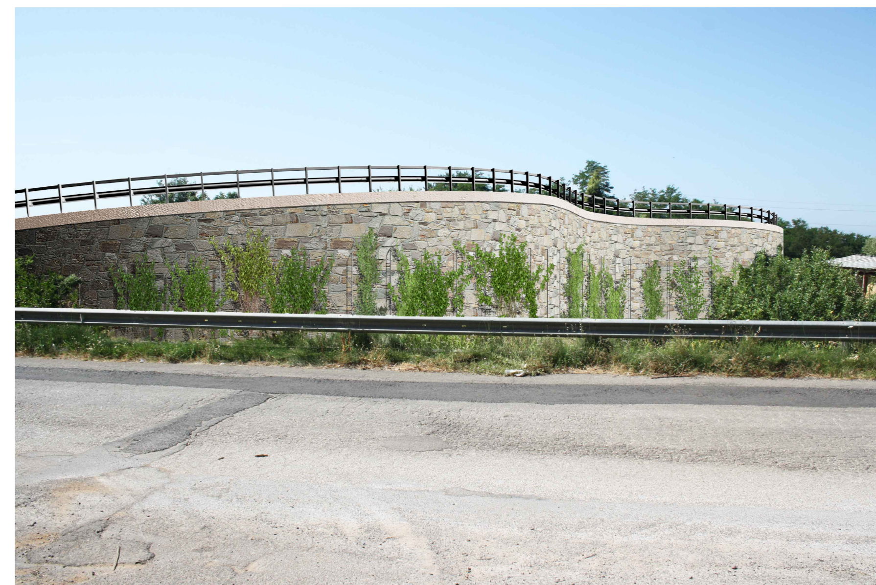
Fotoinserimento n.3 - Post operam - Conparamento murario in pietra
