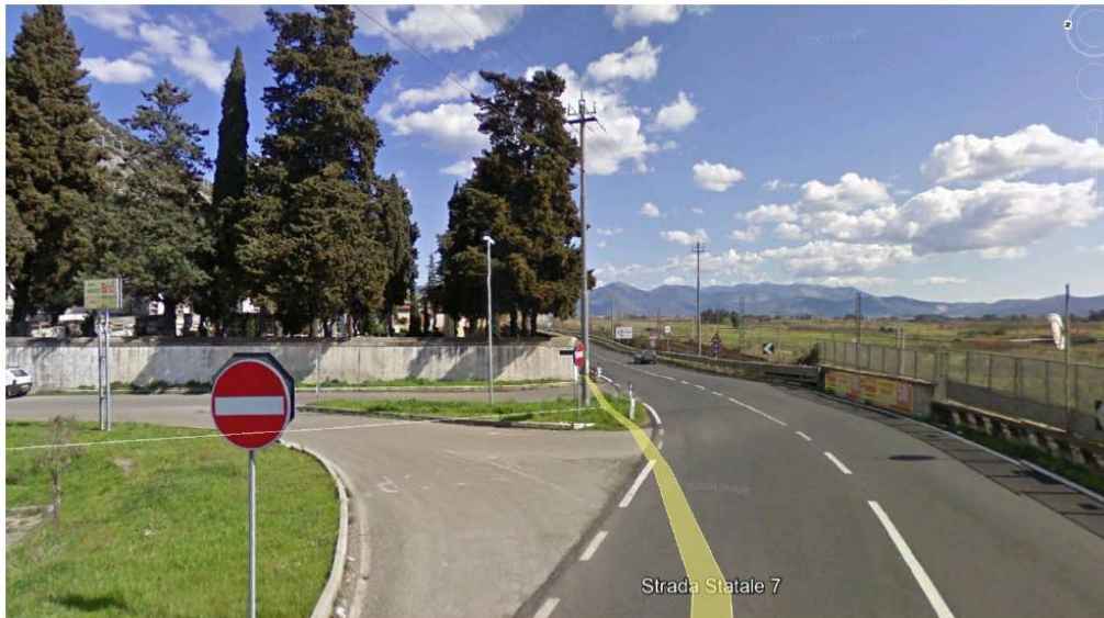
Vista di tratto della S.S. n.7 oggetto di futuri lavori
