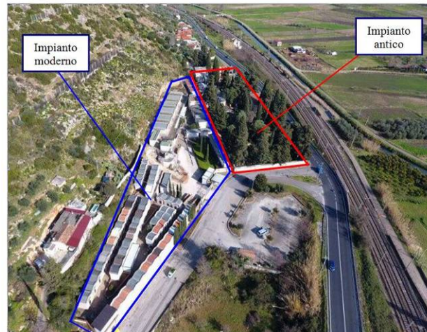
Foto dell'area di intervento
