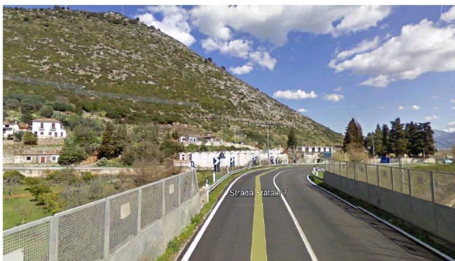
Vista di tratto della S.S. n.7 oggetto di futuri lavori
