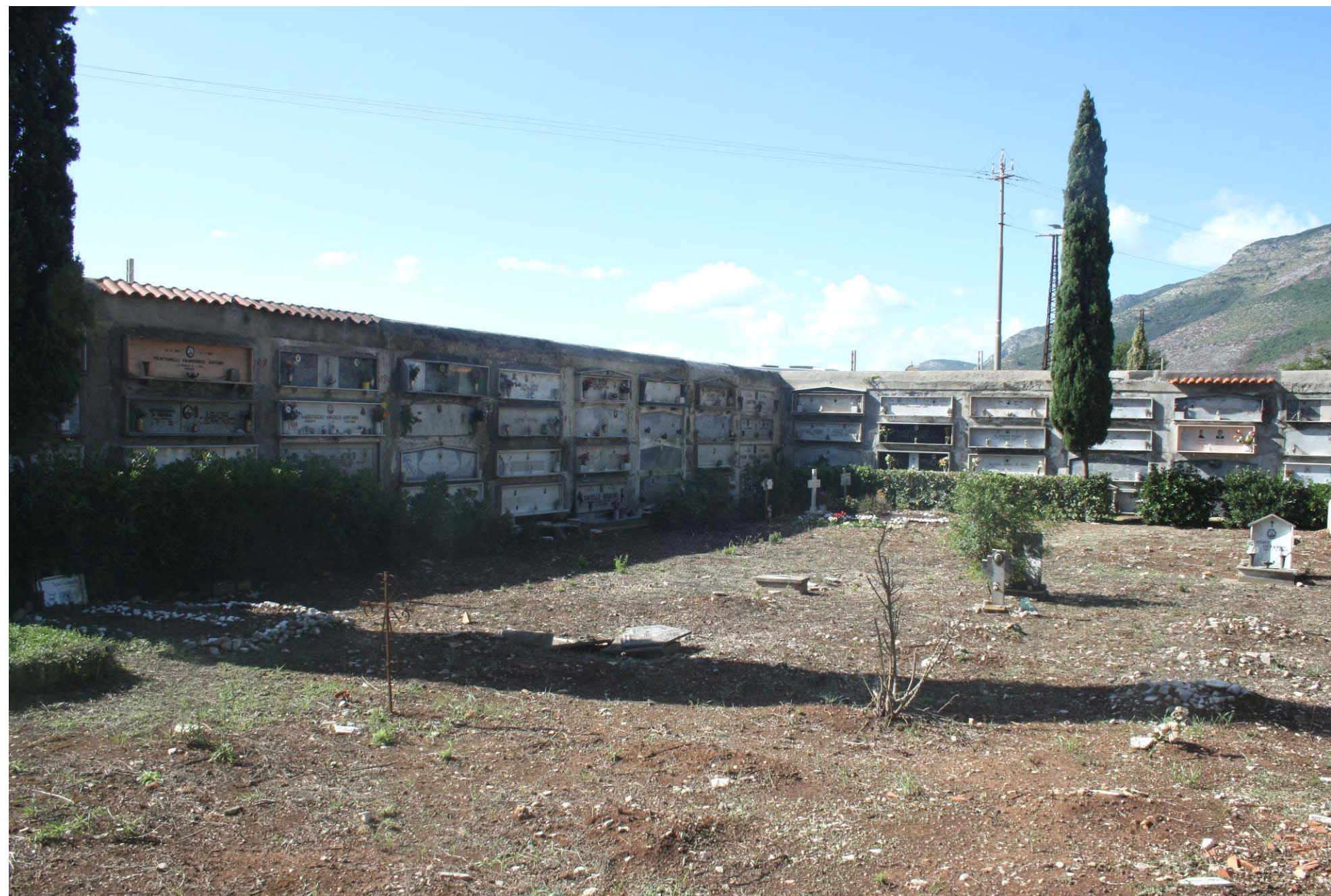
Ante operam - Vista dall'interno dell'area cimiteriale
