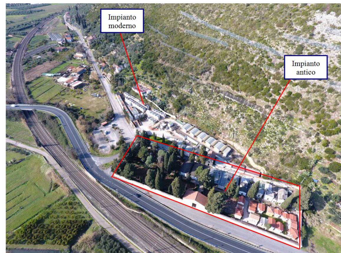
Foto dell'area di intervento
