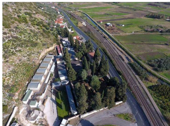
Foto dell'area di intervento
