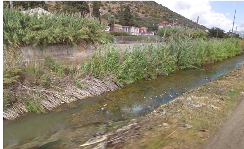
Canale di bonifica a sud della linea ferroviaria
