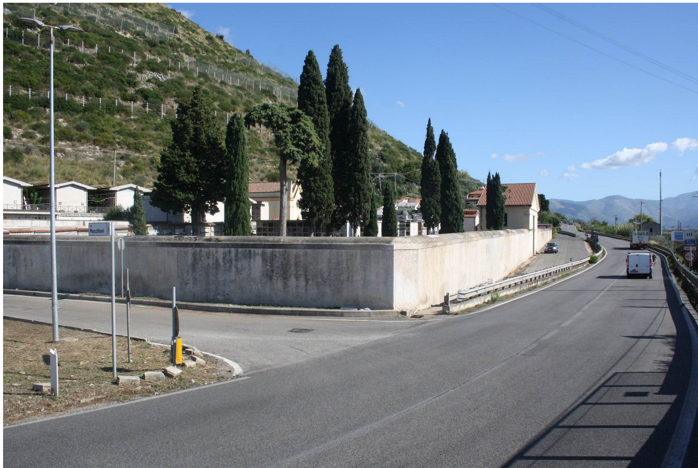
Ante operam - Vista dell'angolo del muro di cinta oggetto di intervento
