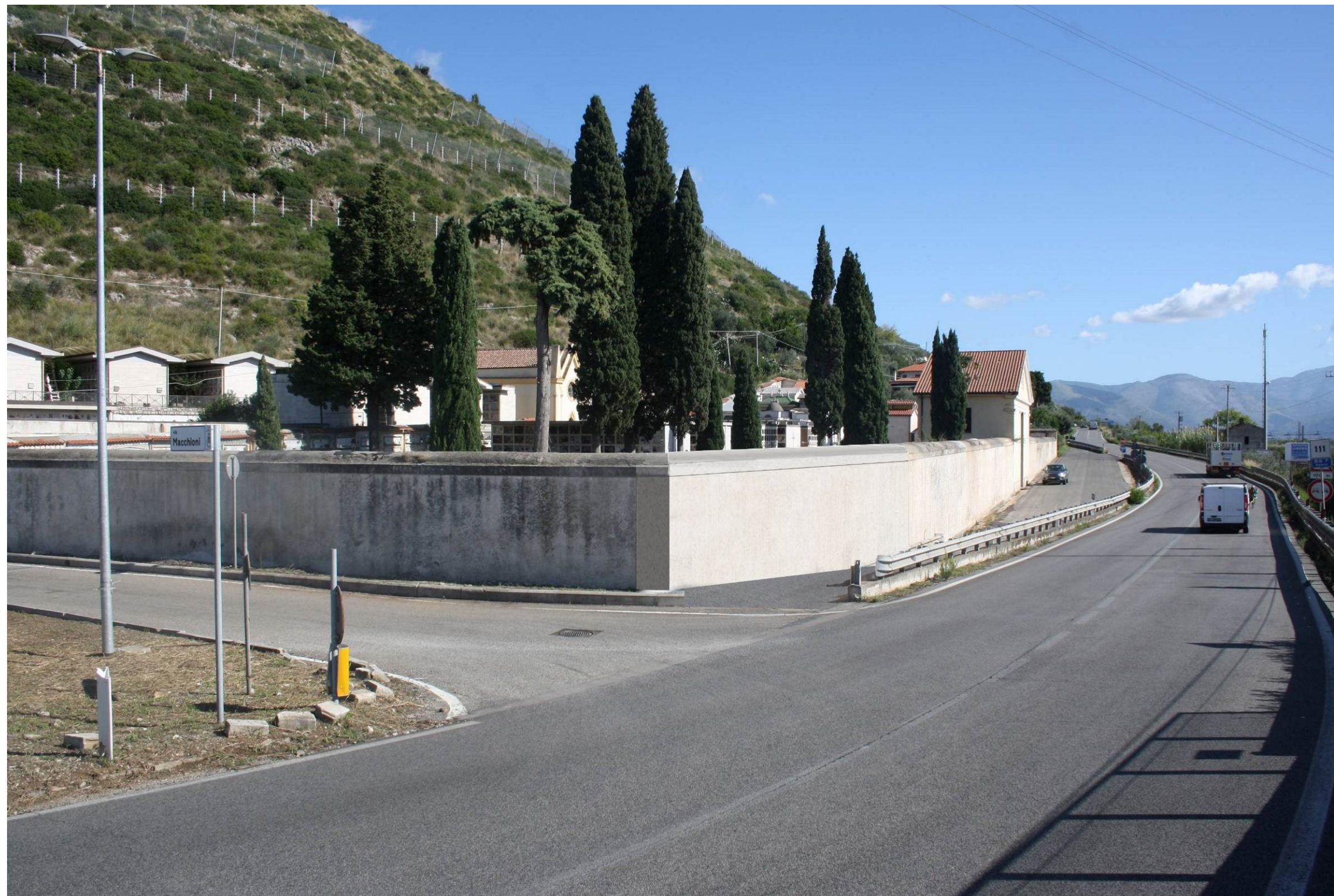
Post operam - Vista dell'angolo del muro di cinta oggetto di intervento
