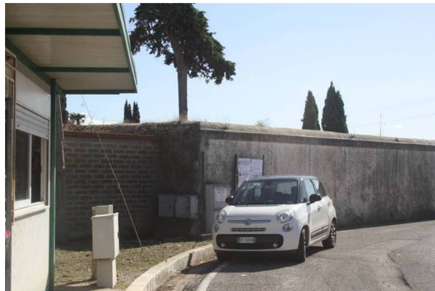
Lato Esterno: Il muro di cinta antico ed il muro di cinta moderno (Via Macchioni)
