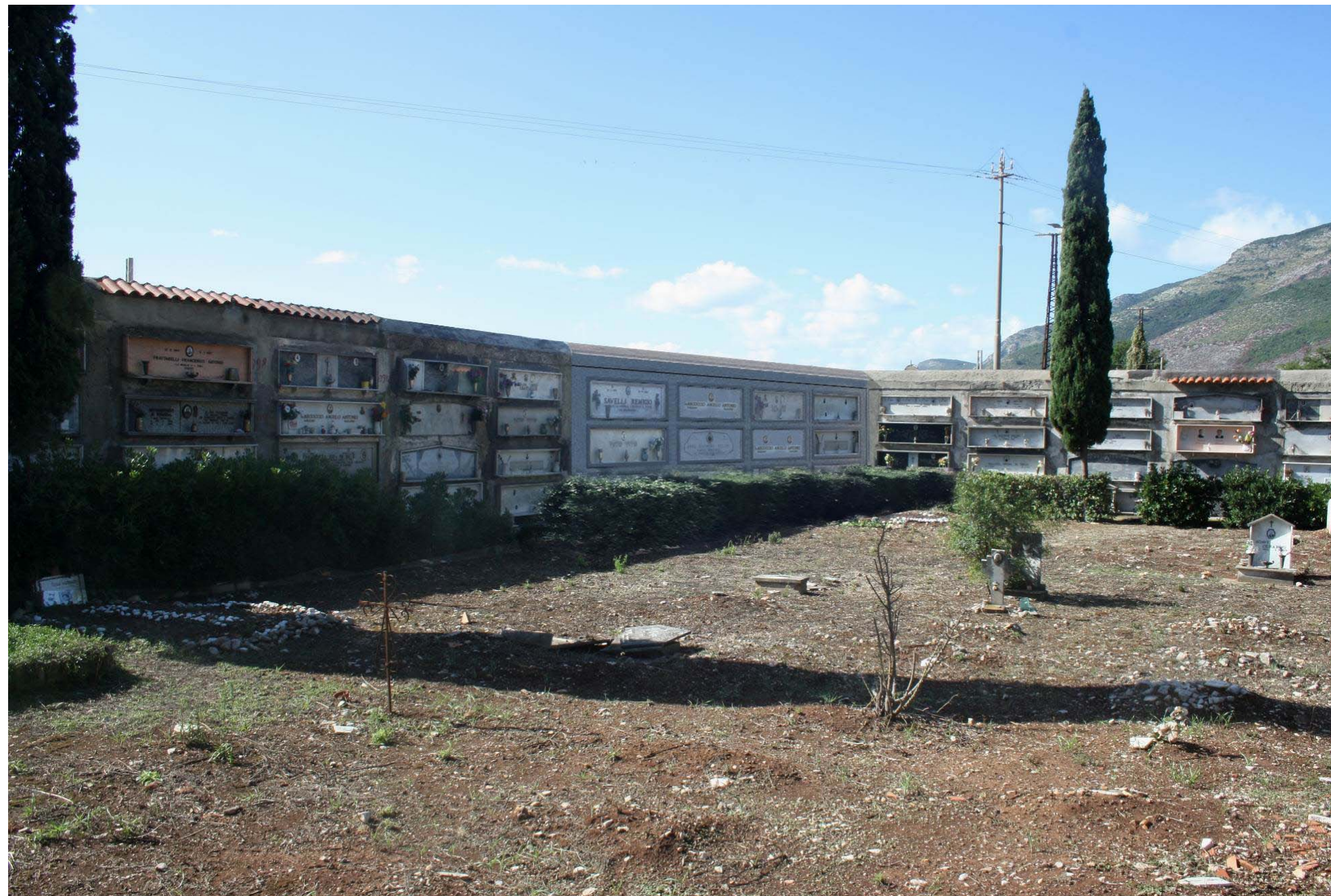
Post operam - Vista dall'interno dell'area cimiteriale
