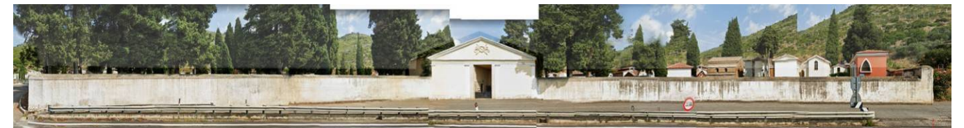
Foto - Prospetto del muro lungo la S.S. n.7 Via Appia
