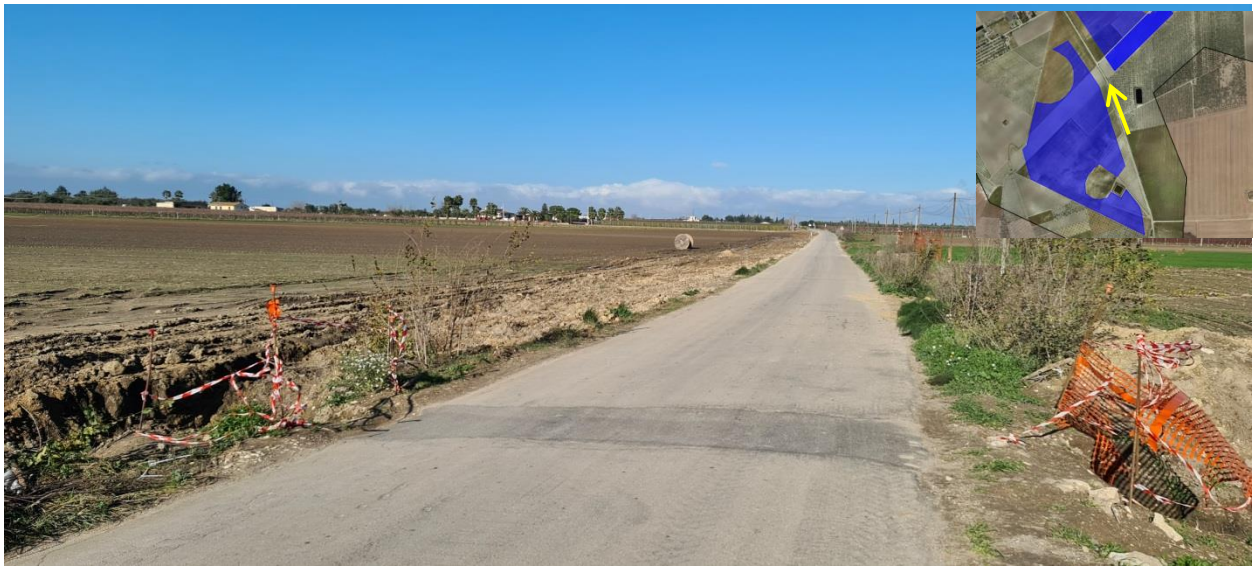
Fig. n.44 Foto interferenza elettrodotto con altri cavi MT interrati
