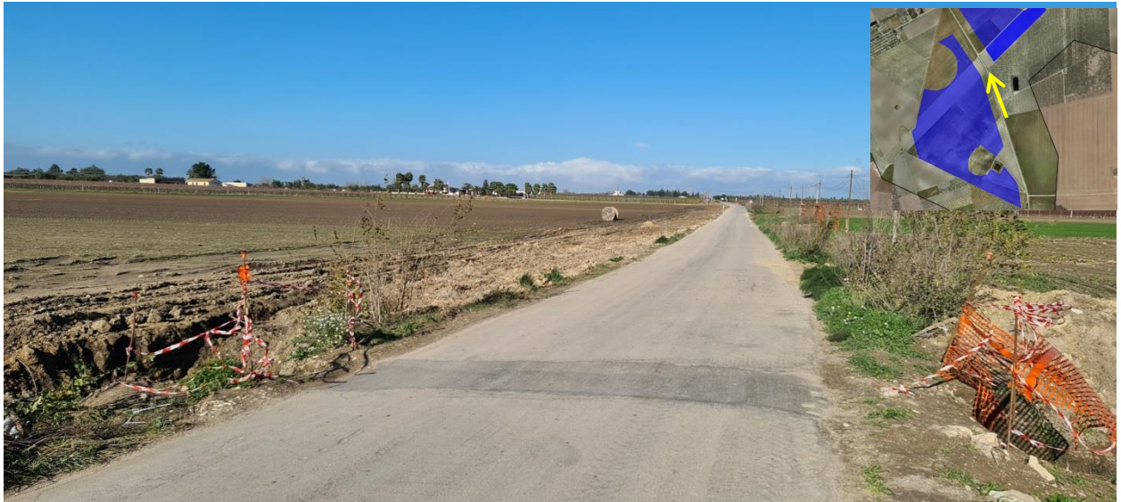
Fig. n.12 Foto interferenza elettrodotto con altri cavi MT interrati
