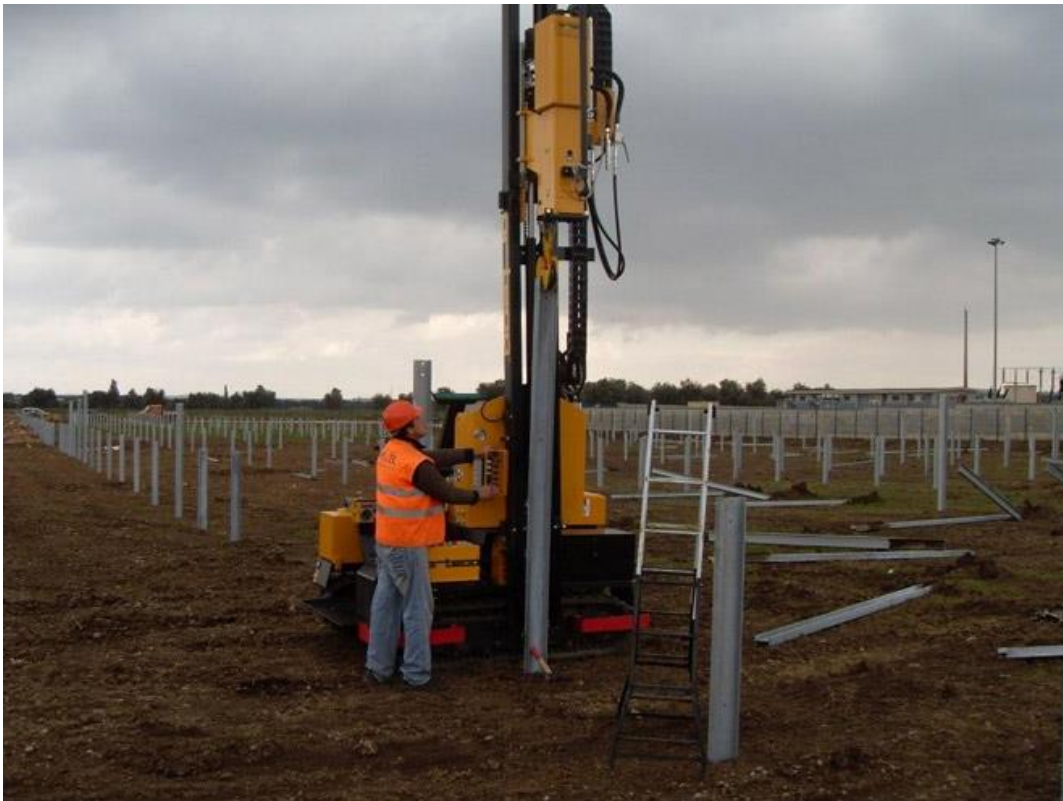
Fig. n°1 Operazione di rimozione dei pali infissi
