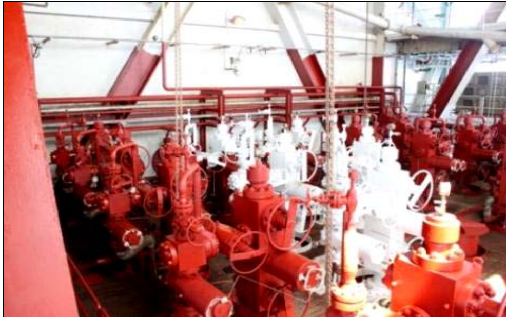
Figura 4.d: Piattaforma Vega A - Teste Pozzo
