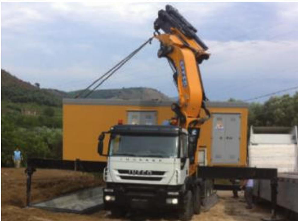
Fig. 18 Operazione di rimozione delle cabine prefabbricate
