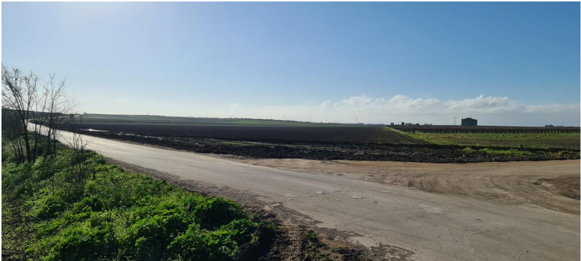
Figura 4-17: Vista del blocco E - F: ante-operam
