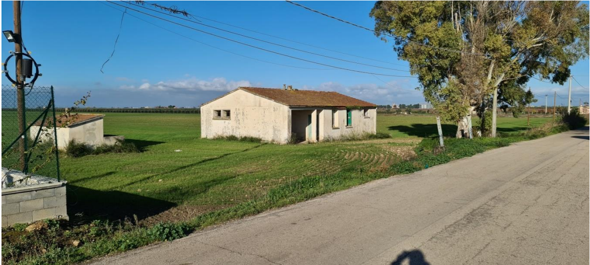
Figura 4-11: Vista del blocco A: ante-operam
