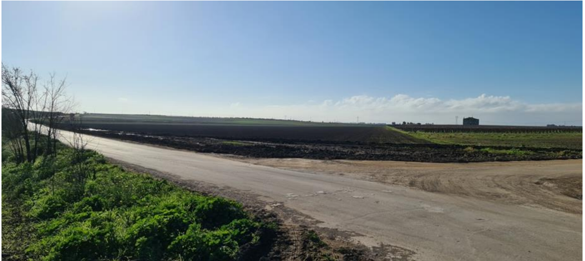
Figura 1-17: Vista del blocco E - F: ante-operam
