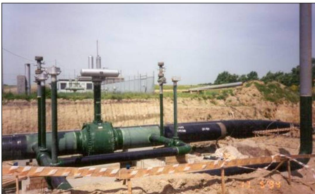
**Foto 2.2-8: Esempio di punto di intercettazione di linea (PIL)**
