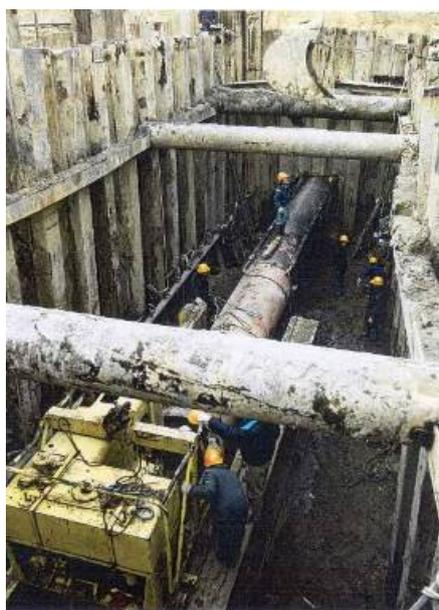
**Foto 2.2-7: Trivellazione con spingitubo**
