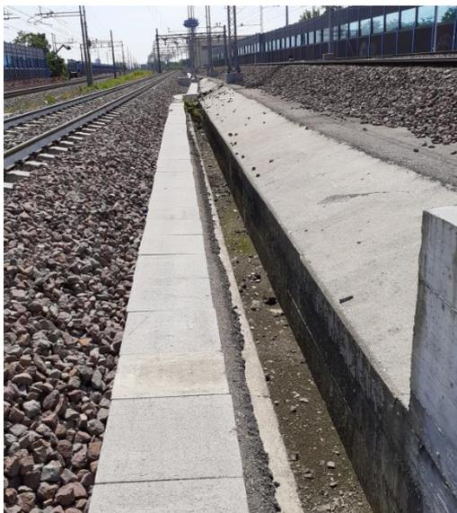
Figura 7 Fotografia 3 – Canalette di raccolta acque meteoriche
