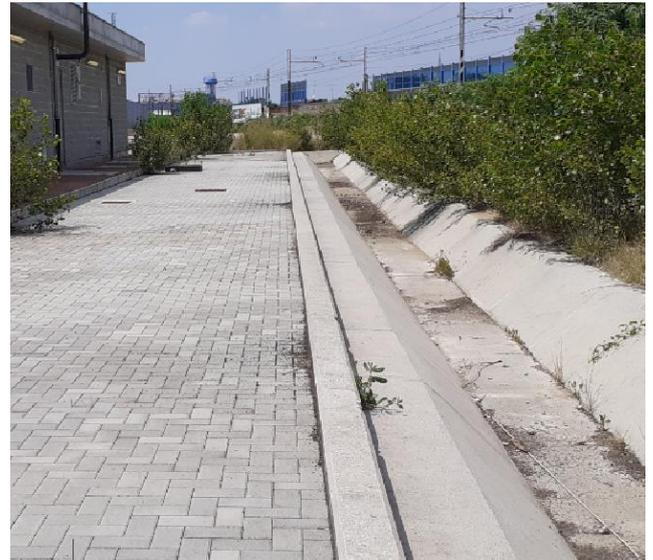
Figura 14 Fotografia 9 – Canaletta di scolo in cls in prossimità del fabbricato
