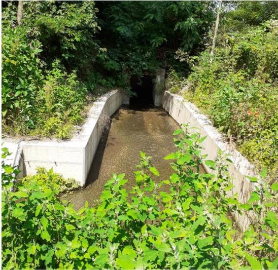
Figura 11 Fotografia 6 – Sbocco attraversamento idraulico della sede ferroviaria (IN01)
