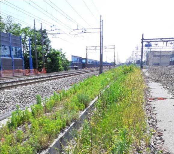
Figura 5 Fotografia 1 – Canalette di raccolta acque meteoriche
