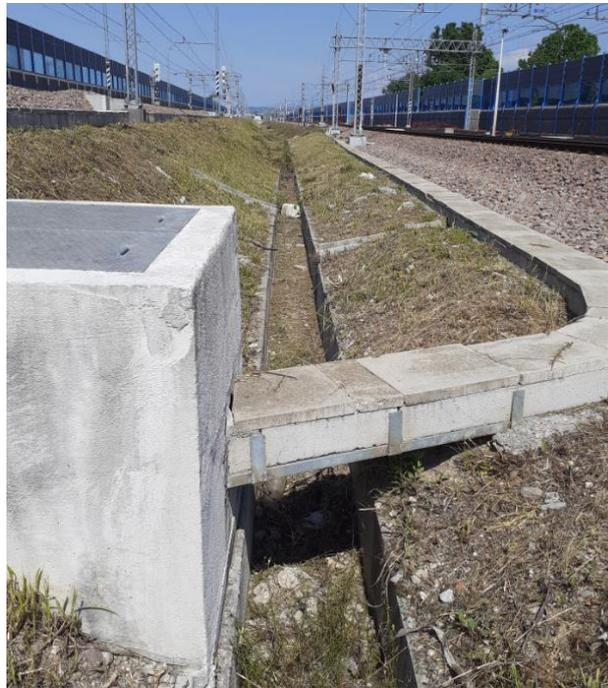
Figura 9 Fotografia 5 –Canaletta di raccolta acque meteoriche
